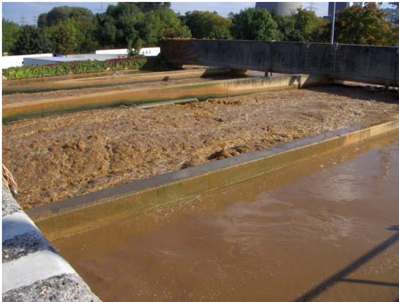
Kuva 10. Biologisen typen poiston altaat meijerijäteveden käsittelyssä (Saksa). Ilmastetun al-lasosion tunnistaa pinnan kuplinnasta. Kuva: Teija Paavola, MTT.
