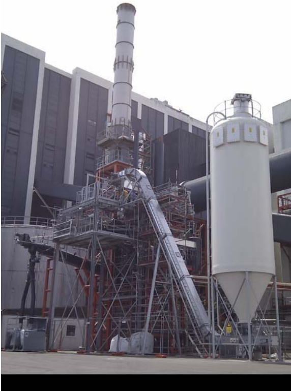
Kuva 15. DONG Energyn valmisteilla oleva (kesä 2011) lantaa ja muita biohajoavia materiaaleja käsittelevä demonstraatiolaitos. Kuva: Ksawery Kuligowski, POMCERT.
