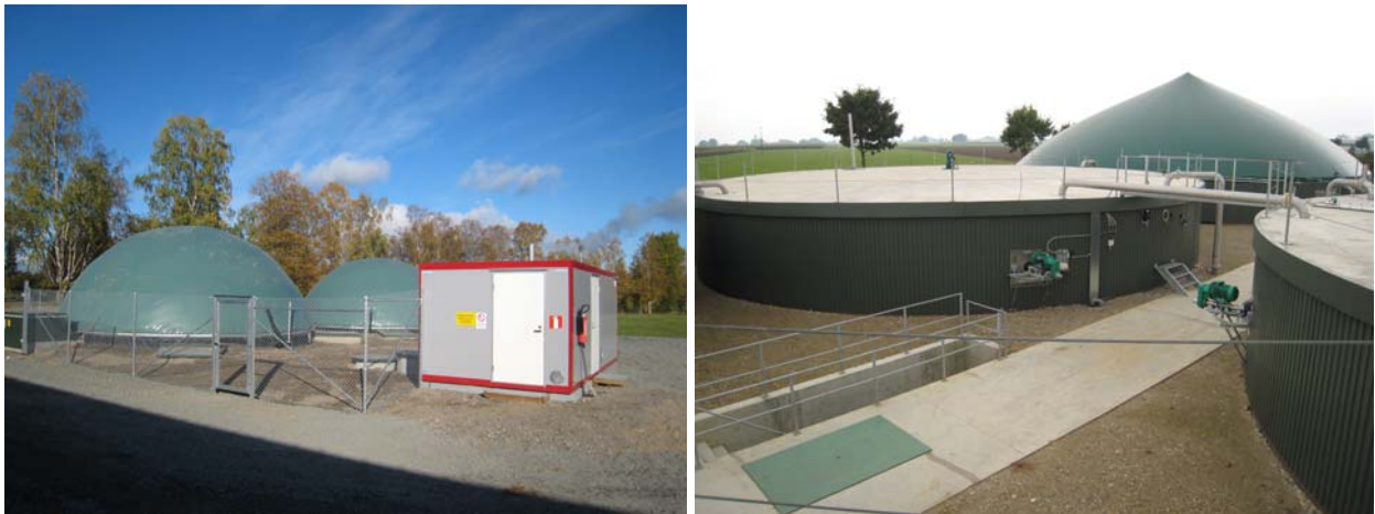
Kuva 3. Maatilamittakaavan jatkuvatoiminen märkäprosessi (MTT Maaningan toimipiste) ja energiakasveja käsittelevä märkäprosessi (Laupheim, Saksa). Kuvat: Sari Luostarinen, MTT.
