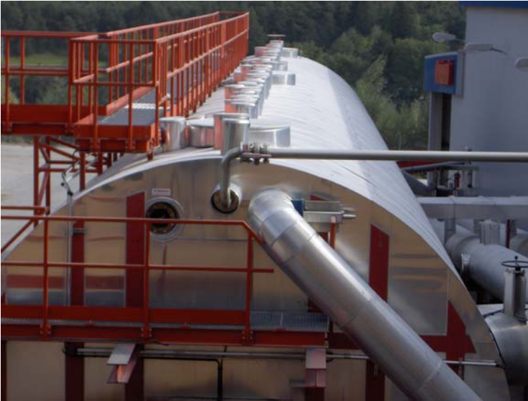
Kuva 4. Tulppavirtausreaktori (Thöni, Itävalta). Kuva: Teija Paavola, MTT.
