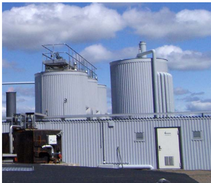
Kuva 17. Hygienisointiprosessin rinnakkaiset säiliöt Biovakka Suomi Oy:n Vehmaan laitoksella. Kuva: Teija Paavola, MTT.
