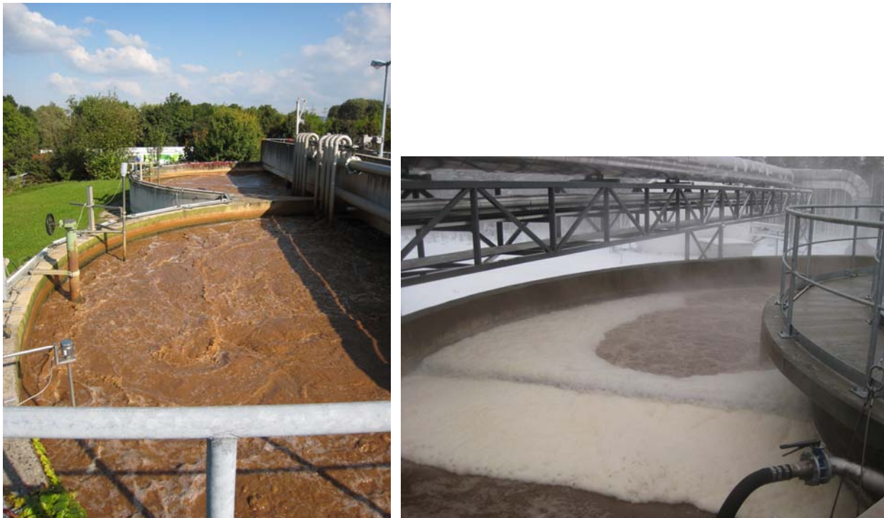
Kuva 8. Oikealla: anaerobisesti esikäsitellyn meijerijäteveden ilmastus (Saksa). Kuva: Sari Luostarinen, MTT. Vasemmalla: biokaasuprosessin rejektiveden ilmastus Lakeuden Etappi Oy:n laitoksella. Kuva: Teija Paavola, MTT.
