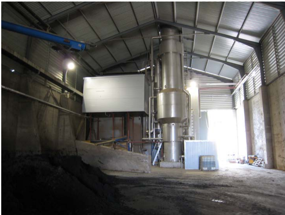
Kuva 24. Strippauskolonni Biovakka Suomi Oy:n Vehmaan laitoksella. Kuva: Sari Luostarinen, MTT.
