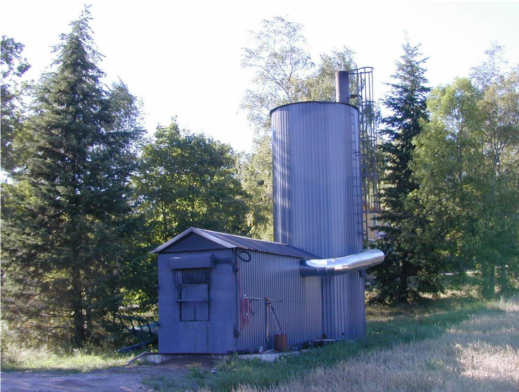
Kuva 8. Hagmanin tilan olkipaalikattila. Paalit työnnetään etukuormaajalla kattilan sisään avaamalla matalamman rakennuksen etuseinä. Vesivaraaja näkyy taaempänä korkeampana. Savupiippu on johdettu vesivaraajan läpi, jolloin osa hukkalämmöstä saadaan talteen. (Kuva: Timo Lötjönen, MTT)
