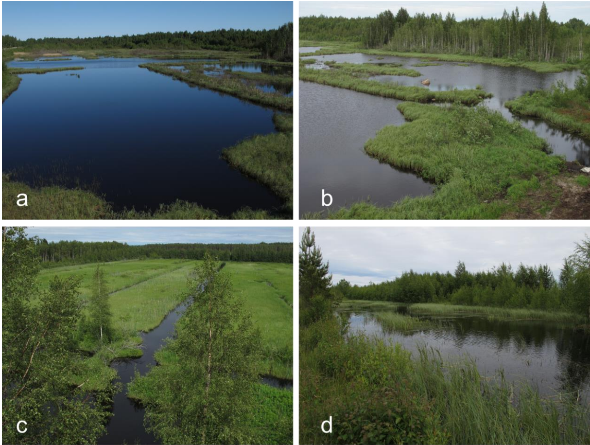
Kuva 25. Vuonna 2006 rakennettu kosteikko 12 (a) ja 15 (b) vuoden jälkeen (Kihniö, Aitoneva). Pinta-ala oli perustamishetkellä 9,3 ha, josta pysyvää avovesipintaa 1,5 ha. Kosteikon ympärille rakennettiin maavallit, jotta vesi pysyy alueella. Hoitotoimenpiteinä kohde on vaatinut mm. pajukon raivausta. Kuvassa c on soistunut, heinittynyt ja pensoittunut kosteikko, jossa vapaita vesialueita on suhteellisen vähän (kokonaispinta-ala noin 5 ha, turpeennoston päättymisestä alle 20 vuotta; Kankaanpää (Honkajoki), Satamakeidas). Kuvassa d on luontaisesti syntynyt kosteikko tuhkalannoitetulla saralla (Isojoki, Helmikäiskeidas). Kuvat: Lasse Aro.
