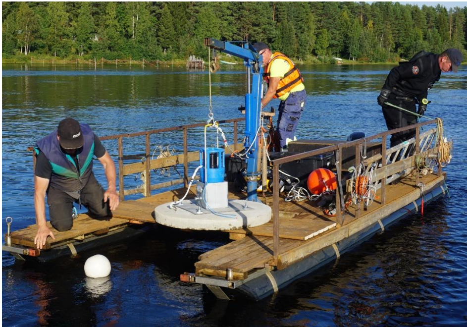
Kuva 4. Karkotinten asennus elokuussa lijoelle. Karkotinyksikkö on kiinnitetty 120 kg betonipainoon paikallaan pysymisen varmistamiseksi. Kuva Petri Suuronen.
