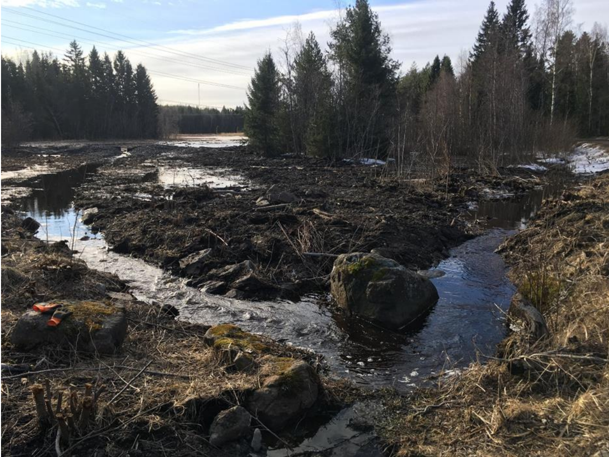
Kuva 47. Sävviken kunnostuksen jälkeen huhtikuussa 2021. Lasku-uoman lisäksi ohivirtaamaa tuli kuvan oikeassa reunassa näkyvän maantieojan kautta. Ohivirtaama estettiin patoamalla vuotokohta altaan reunalta maamassalla. Kuva: Lari Veneranta.
