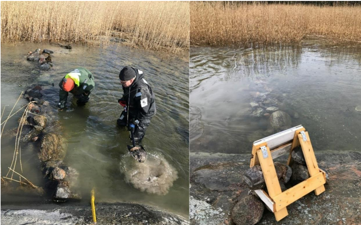
Kuva 20. Ytteröfladan suuaukon patoaminen kivillä, hiekkasäkeillä ja irtosoralla (vasen kuva). Veden virtaus fladan ja meren välillä oli ajoittain voimakasta (oikea kuva) meriveden pinnan noustessa padon yläreunaa korkeammalle. Kuvat: Mats Westerbom.
