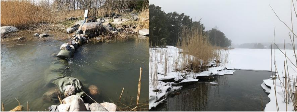
Kuva 25. Veden virtausta fladan ja merialueen välillä pyrittiin vähentämään kivistä, hiekasäkeistä ja sorasta kootulla patorakennelmalla. Voimakas virtaus pitää suuaukon sulana myös talvella. Kuvat: Mats Westerbom.
