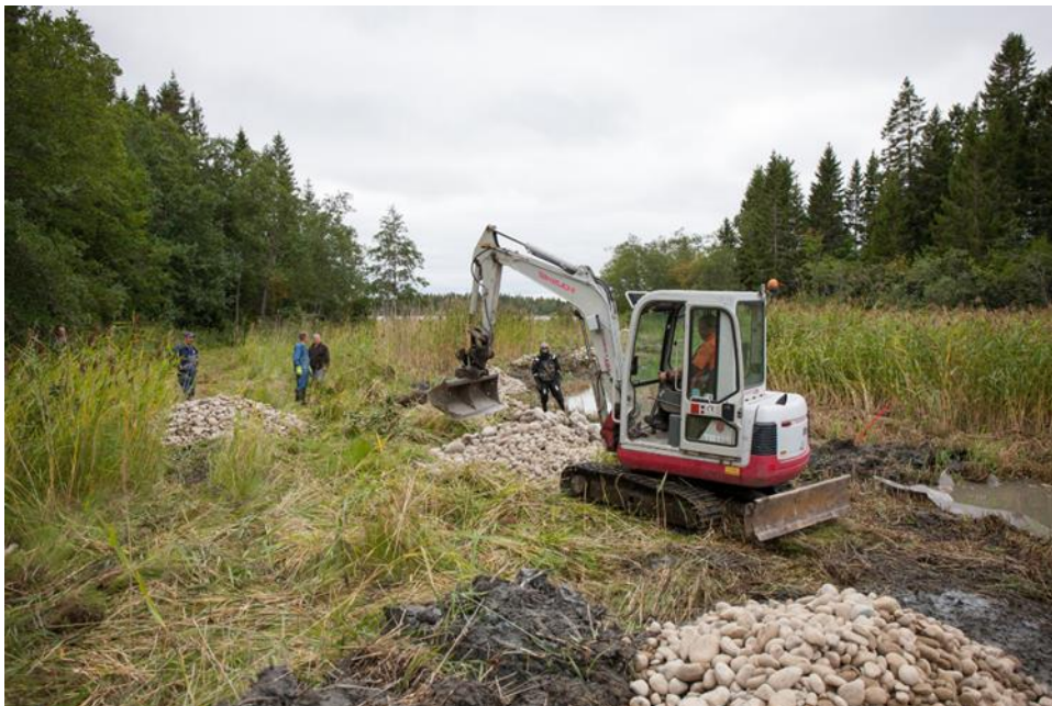
Kuva 37. Backfladan lasku-uoman kunnostusta kaivinkoneella. Kuva: Lari Veneranta.
