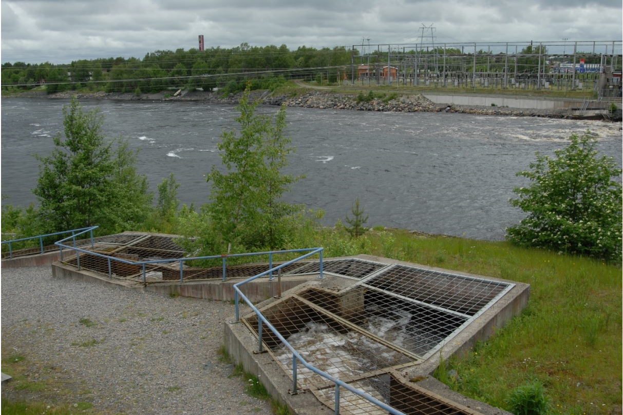
Kuva 3. Vallitunsaaren kalatien keskiosaa, joka koostuu Denil-osuuksista ja niiden välissä olevista lepoaltaista. Kuva: Panu Orell.
