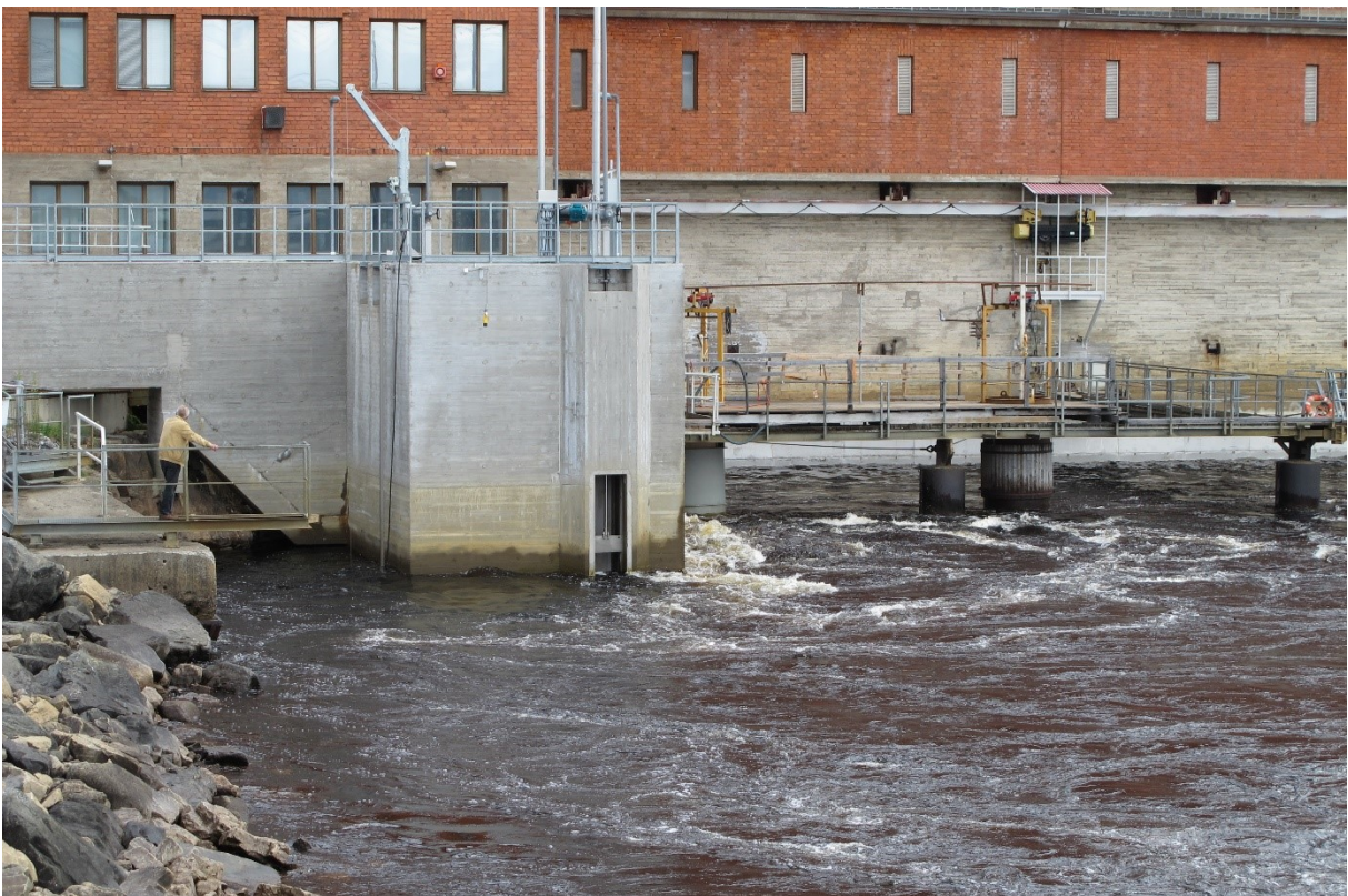
Kuva 4. Isohaaran uuden kalatien alempi sisäänkäynti ja kalatien alaosan betoninen Borland-kammio. Kuva: Panu Orell.
