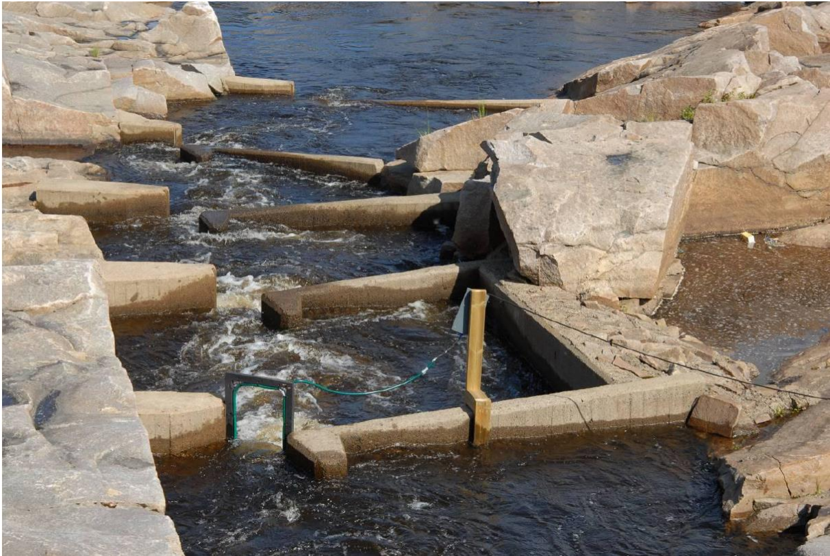
Kuva 7. PIT-antenniyksikkö asennettuna Oulujoen Merikosken yläkalatien pystyrakoaukkoon. Kuva: Panu Orell
