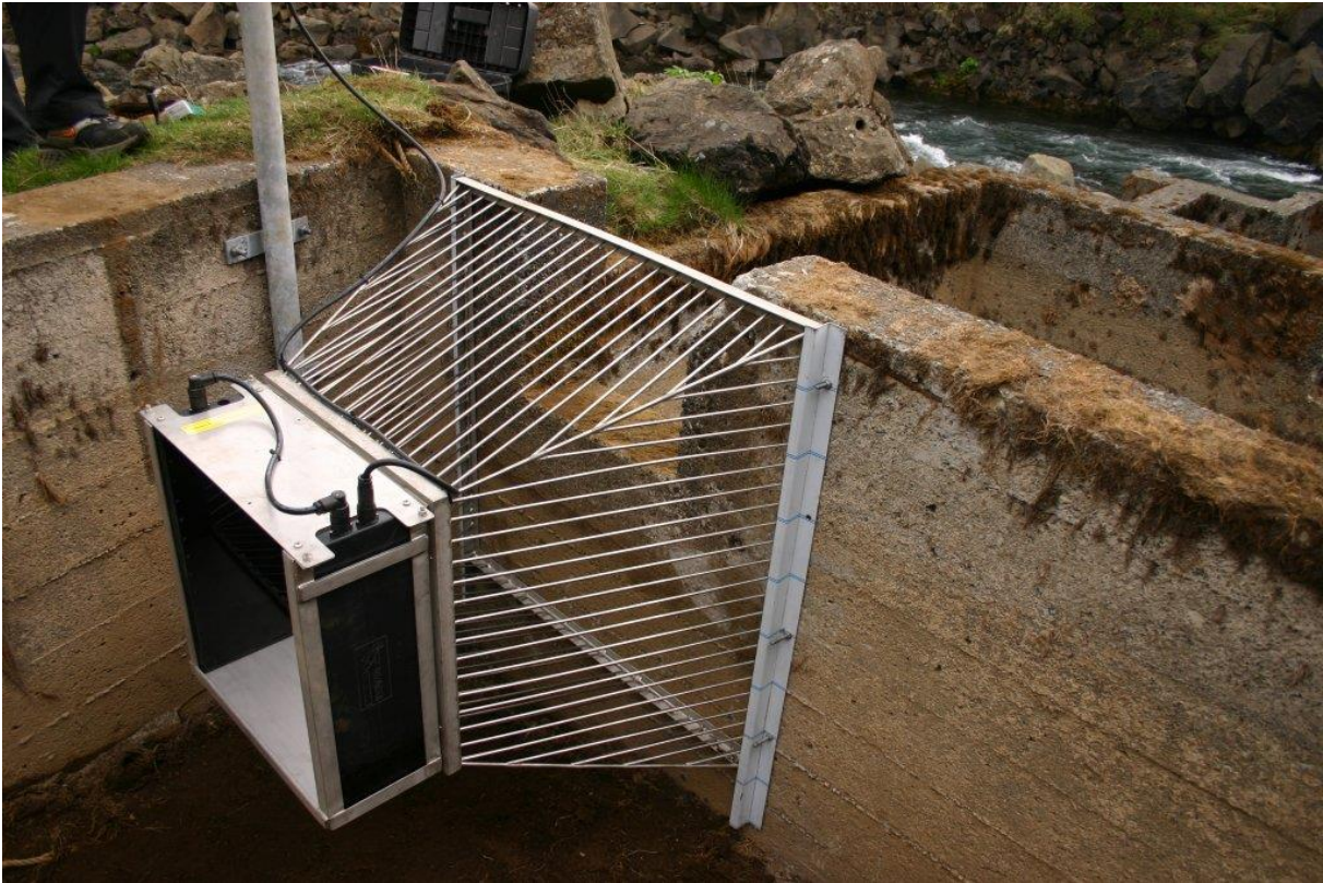
Kuva 1. Vaki-laskuri asennettuna kalatien ylivirtausaukkoon. Kuva: Vaki Aquaculture Systems Ltd.
