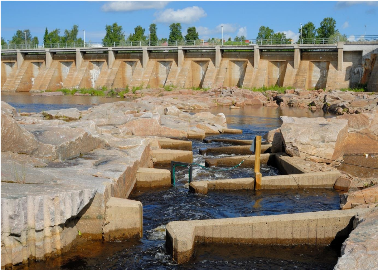
Kuva 13. Merikosken yläkalatien alaosaan asennettu PIT-lukijaysikkö. Lähde. Orell ym. (2014).
