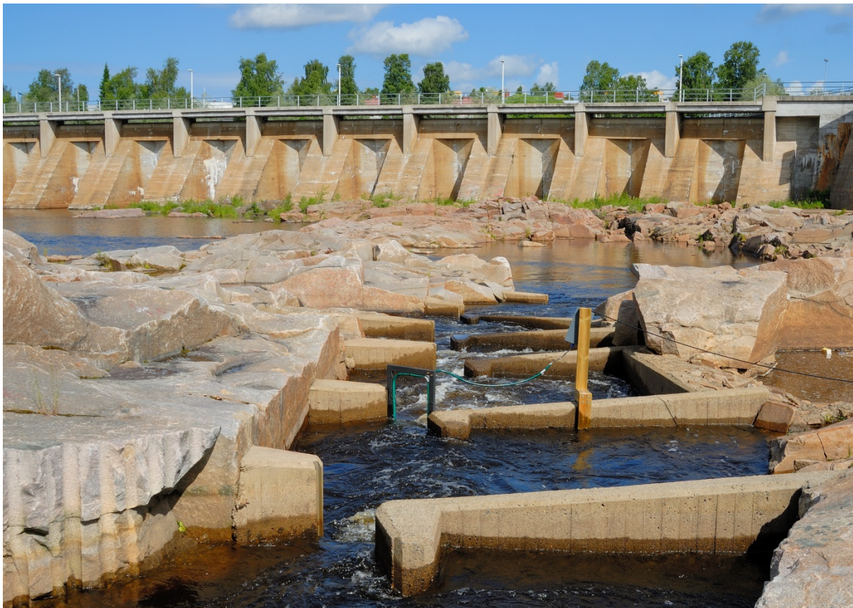
Kuva 7. PIT-antenniyksikkö asennettuna Merikosken kalatiehen. Kuvassa on PIT-antenni nro 3 Merikosken yläkalatien alaosassa. Kuva: Panu Orell.
