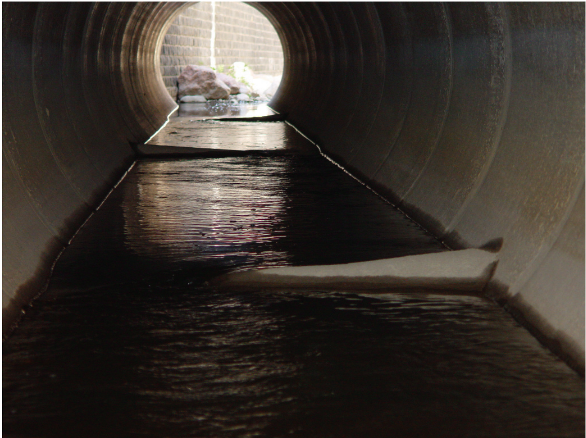
Syksyllä 2004 Monikonpurossa oli runsaasti vettä kudulle pyrkiville emotaimenille. Putkiosuuksilla taimenen nousua helpottavat suisteet, jotka hidastavat veden virtausta putkien pohjalla.
