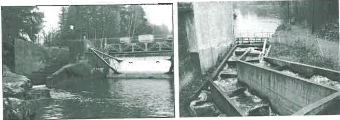
Kuva 2. Kymijoen Koivukosken säännöstelypadon ja voimalaitoksen kalatiet (kuvat: P. Korhonen).
