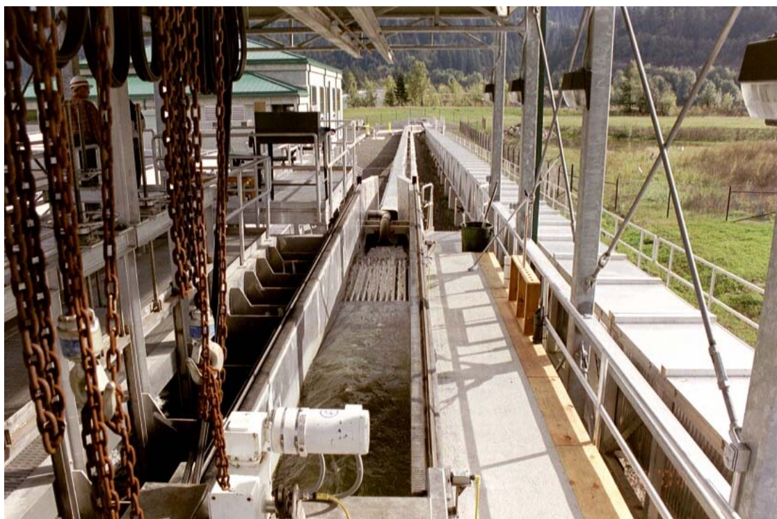
Kuva 17. Alaslaskeutuvien smolttien tutkimusta varten rakennettu kuljetuslinja, joka jatkuu taustalla olevan tutkimusrakennuksen läpi. Poikaset menevät keskellä näkyvän ritilälajittelijan läpi ja putkeen eksyneet suuremmat kalat jatkavat matkaa suoraan eteen päin.
