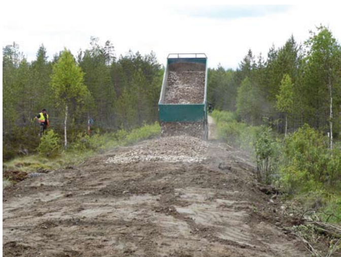
Kuva 2.12. Vanha materiaali tasoitetaan ja päälle levitetään murskekerros (Kuva: Jari Ilomäki 2010).
