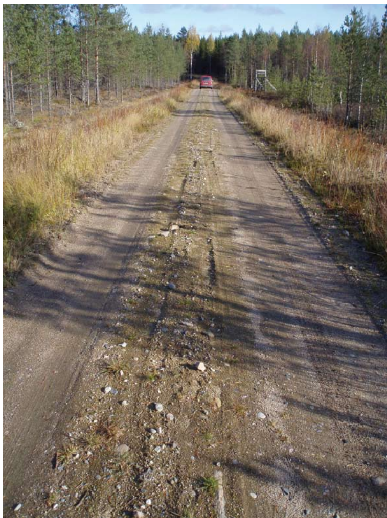
Kuva 3.6. Kelirikkoaikaan heikon kantavuuden omaava pidempi tienkohta (Kuva: Tomi Kaakkurivaara 2010).
