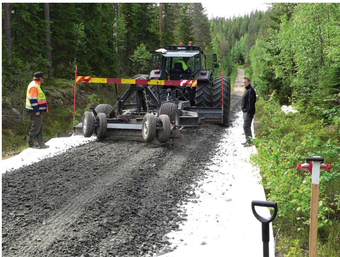
Kuva 2.1. Murske levittiin suodatinkankaan päälle ja lanattiin tasaiseksi (Kuva: Jari Ilomäki 2010).
