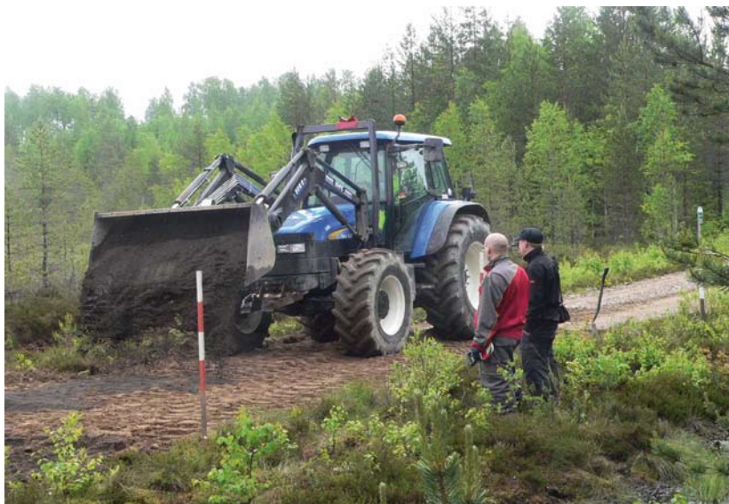
Kuva 2.6. Masuunihiekka-teräskuona siirretään kasalta ja levitetään traktorin avulla muutama metri kerrallaan (Kuva: Jari Ilomäki 2010).
