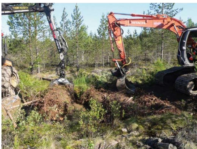
Kuva 2.10. Risutukit tuodaan varastolta metsätraktorilla ja nostellaan tienpohjalle. Kaivuri siirtää risutukit lähelle (Kuva: Jari Ilomäki 2010).
