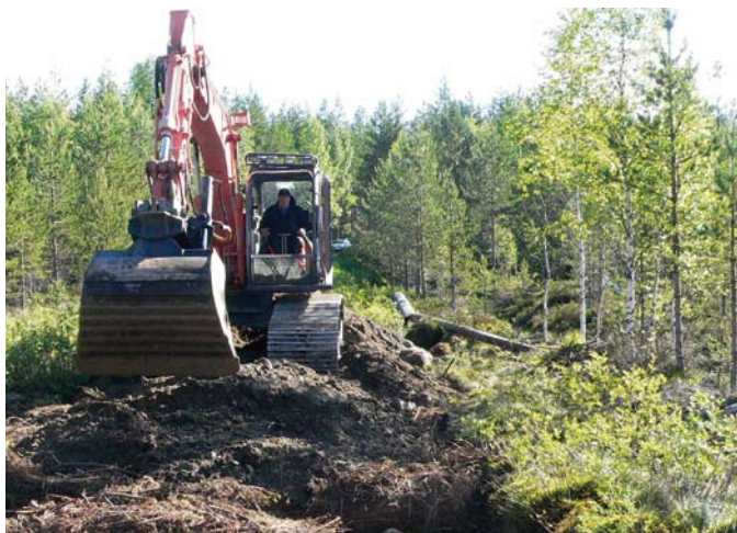
Kuva 2.11. Tien vanha materiaali siirretään kaivurin takaa takaisin tielle asennettujen risutukkien päälle (Kuva: Jari Ilomäki 2010).
