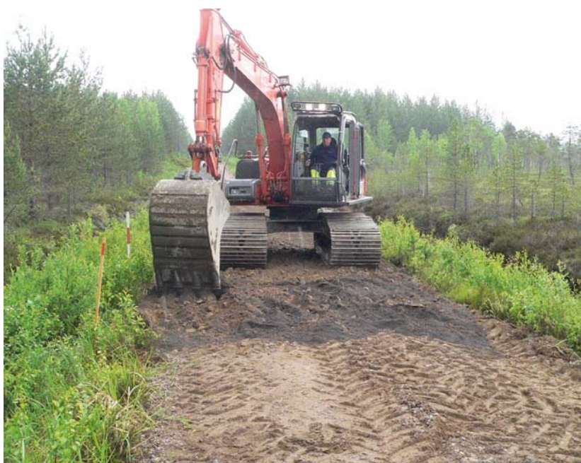
Kuva 2.7. Masuunihiekka-teräskuona sekoitetaan tien pintakerrokseen pitkäpiikkisellä kauhalla (Kuva: Jari Ilomäki 2010).
