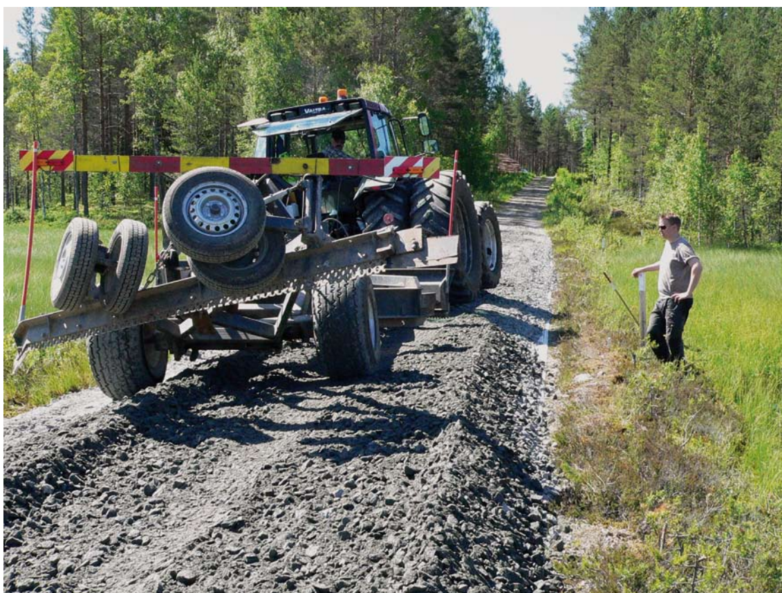
Kuva 2.5. Verkon päälle levitetty karkeampi murske tasattiin ja muotoiltiin ennen kulutuskerroksen levittämistä (Kuva: Jari Ilomäki 2010).
