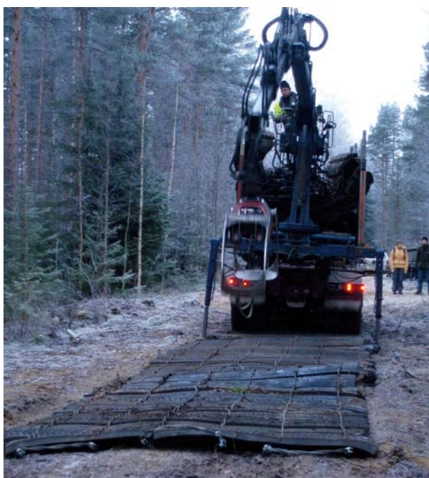
Kuva 3.4. Kumimatot levitetään vetoauton kuormatilasta tielle nosturin avulla (Kuva: Tomi Kaakkurivaara 2009).
