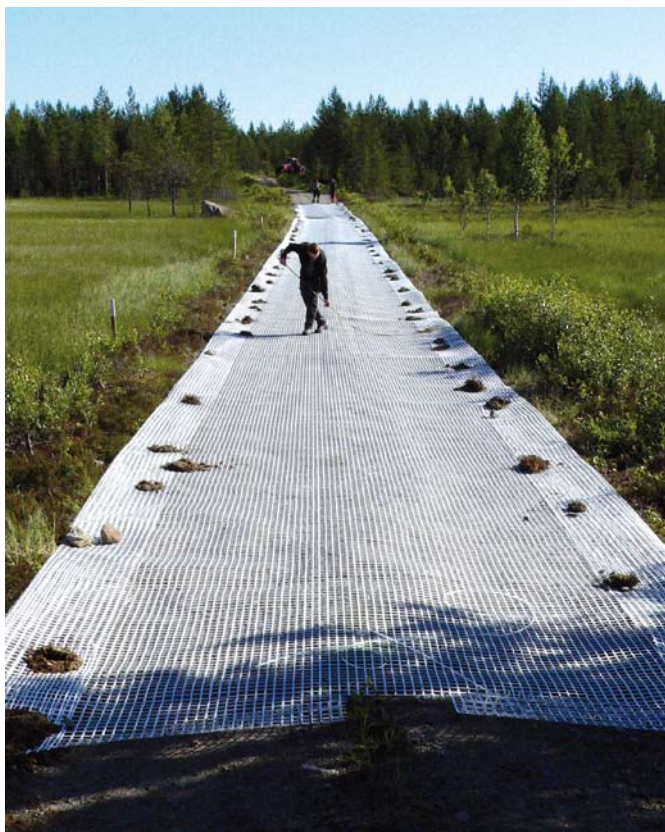
Kuva 2.4. Geoverkko rullattiin suoraan vanhan tien päälle. Leveyden vuoksi reunat jouduttiin kääntämään kaksinkerroin (Kuva: Jari Ilomäki 2010).
