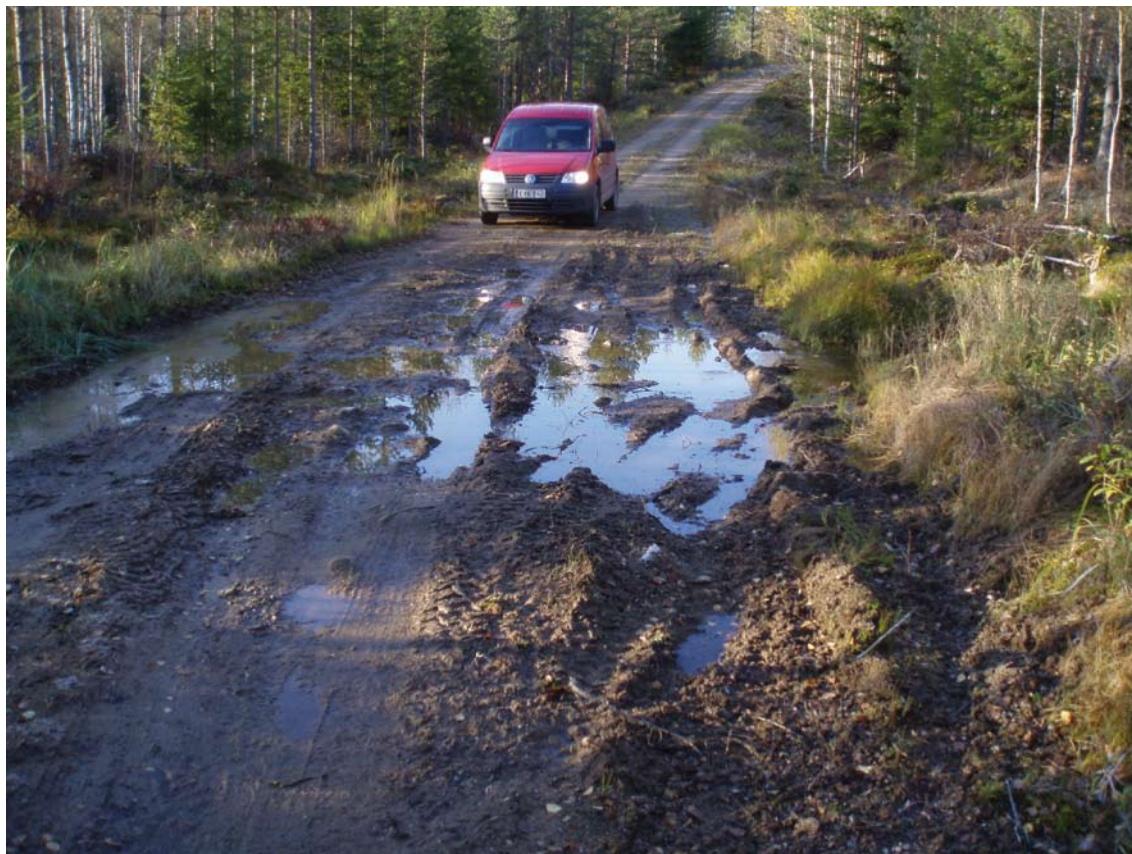
Kuva 3.5. Lyhyt heikkokuntoinen kohta muuten riittävän hyväkuntoisella tiestöllä aiheuttaa vaikeuksia (Kuva: Tomi Kaakkurivaara 2010).
