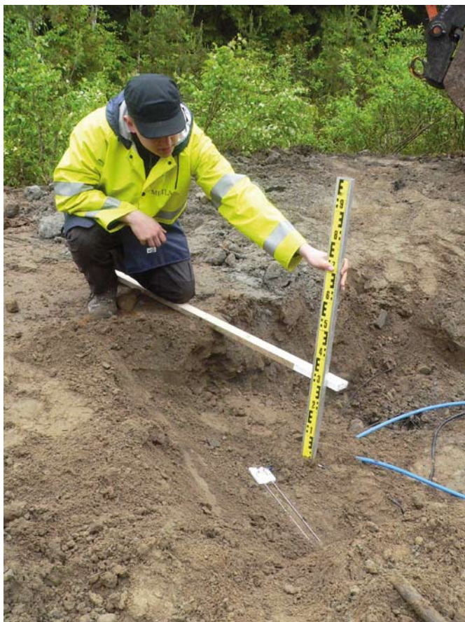
Kuva 2.8. Koealalle asennettujen lämpötila- ja kosteusantureiden sijainnit ja syvyydet dokumentoitiin (Kuva: Jari Ilomäki 2010).
