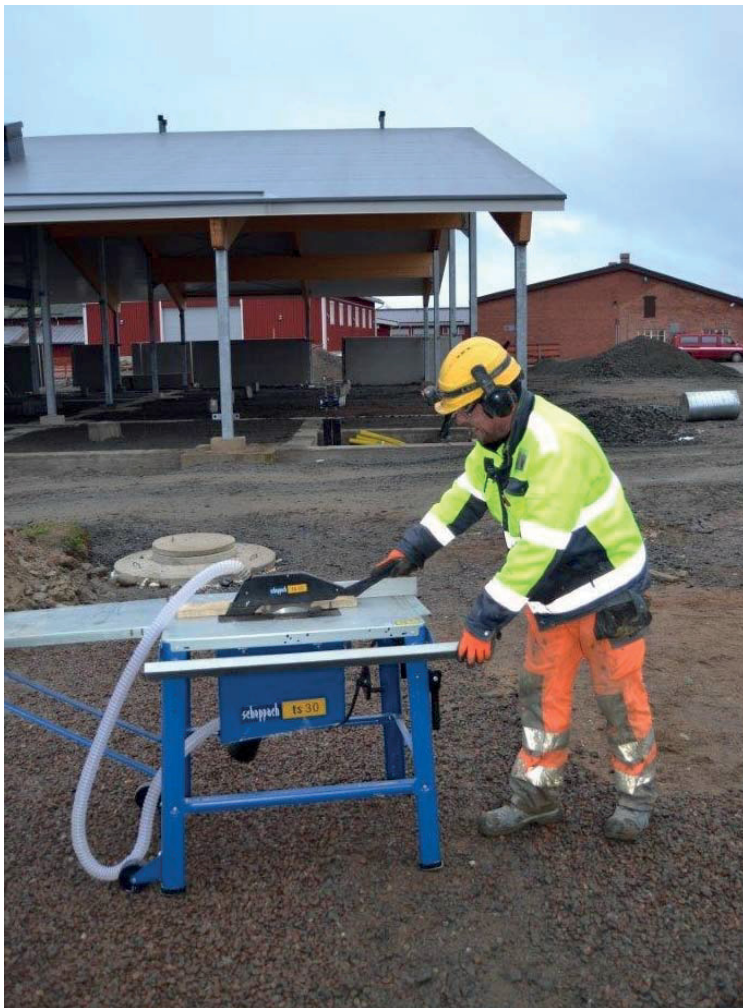
Kuva 3. Henkilökohtaiset suojaimet ovat tarpeen jokaisella rakennustyömaalla. Kuva Jouni Niemi.
