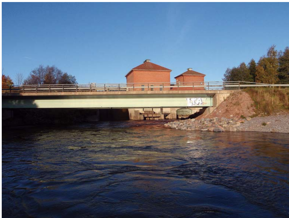
Kuva 3. Tie nro 186 ylittää Peltokosken voimalaitoksen alapuolella.
