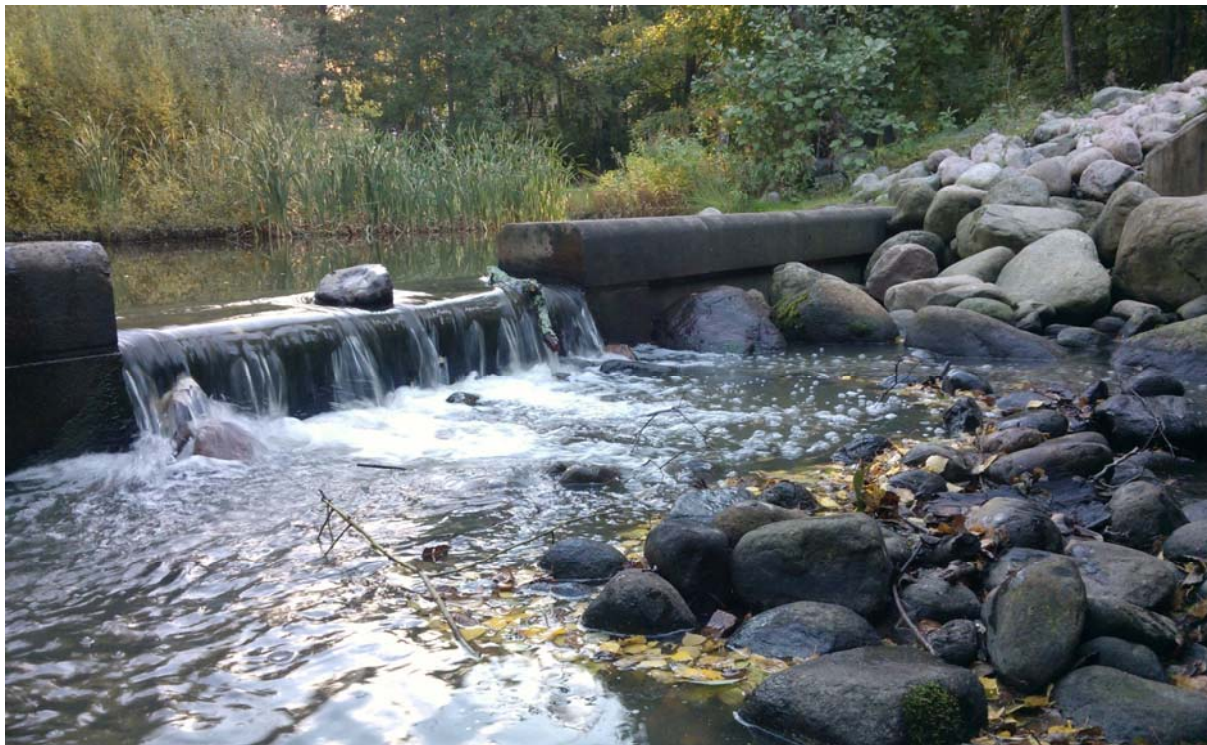
Kuva 9. Koealan 4 yläreuna rajoittuu betoniseen pohjapatoon.
