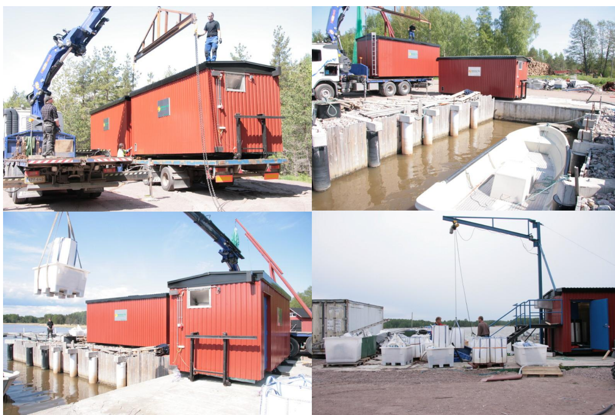
Kuva 39. Hapotusyksikön asennus Kopparnäsin rantaan. (Kuvat: Klaus Berglund).
