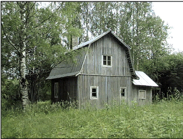
Kuva 17. Ala-Murhin tilan autioitunut päärakennus. Kuva: Metla - Lasse Lovén.
