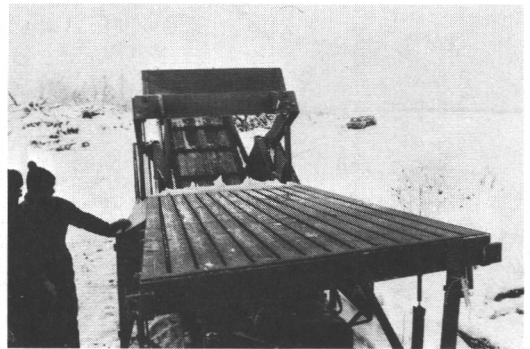
Kuva 16. Arinarakenteinen syöttölava. Oikeassa alakulmassa näkyy yksi syöttöritilän iskuvaimentajista.
