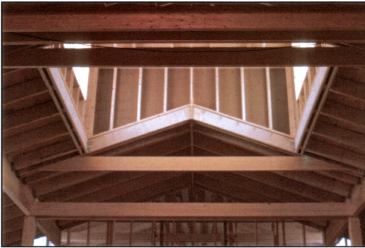
Kuva 11. Liimapuurakenteet ovat potentiaalinen pienpuun käyttökohte. Heinävaaran koulu, Kiihtelysvaara. Kuva: Erkki Verkasalo
