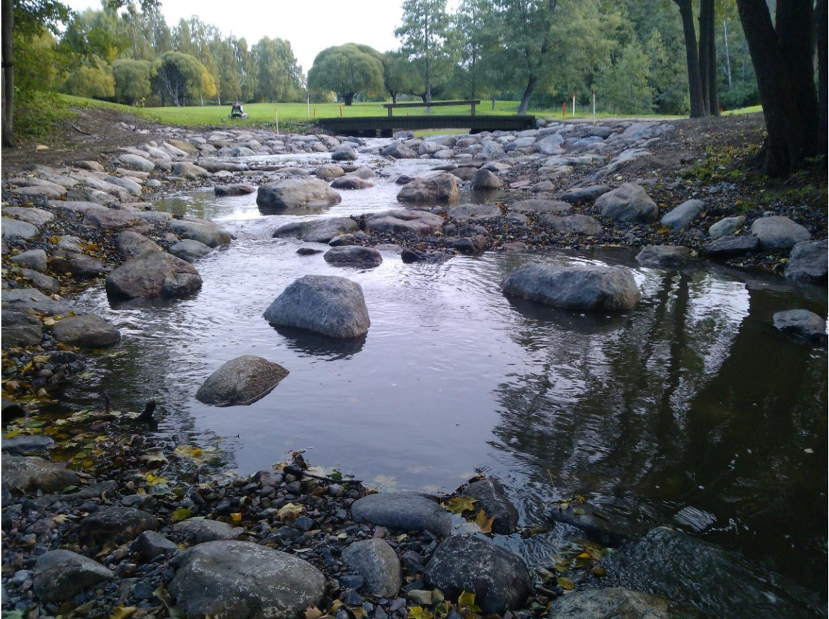
Kuva 3. Koealan 1 ja kastelulammen välissä sijaitseva pohjapato oli muutettu tekokoskeksi, jota pitkin kaloilla on vapaa nousuyhteys merestä Mätäjokeen.
