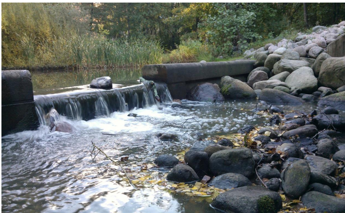
Kuva 7. Koealan 4 yläreuna rajoittuu betoniseen pohjapatoon.
