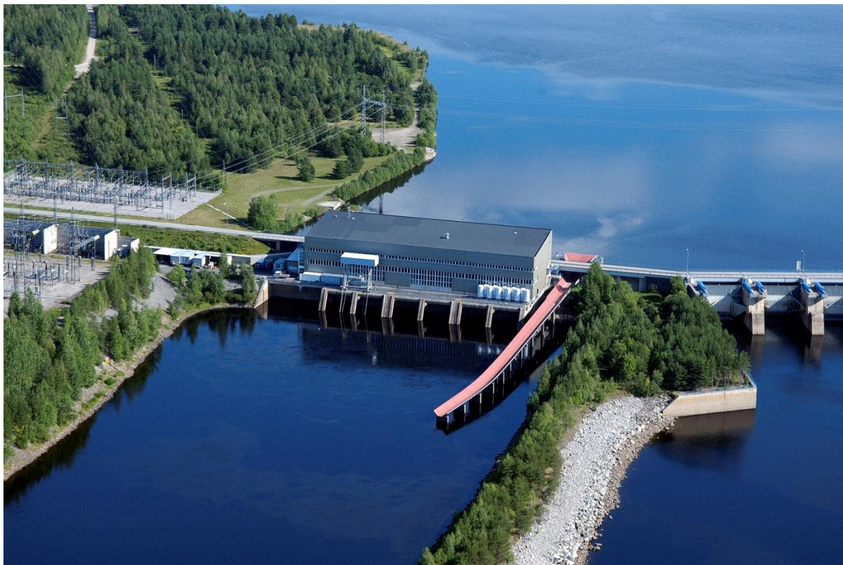
Kuva 6. Valajaskosken voimalaitos. Kuva: Kemijoki Oy.
