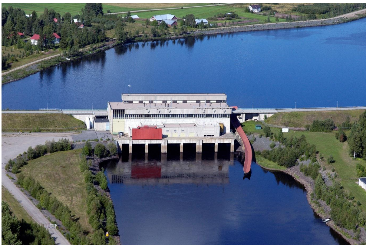
Kuva 2. Ossauskosken voimalaitos. Kuvan oikeassa alareunassa näkyy kalanviljelylaitoksen poistoputken suu (valkoinen kuuhu). Kuva: Kemijoki Oy.
