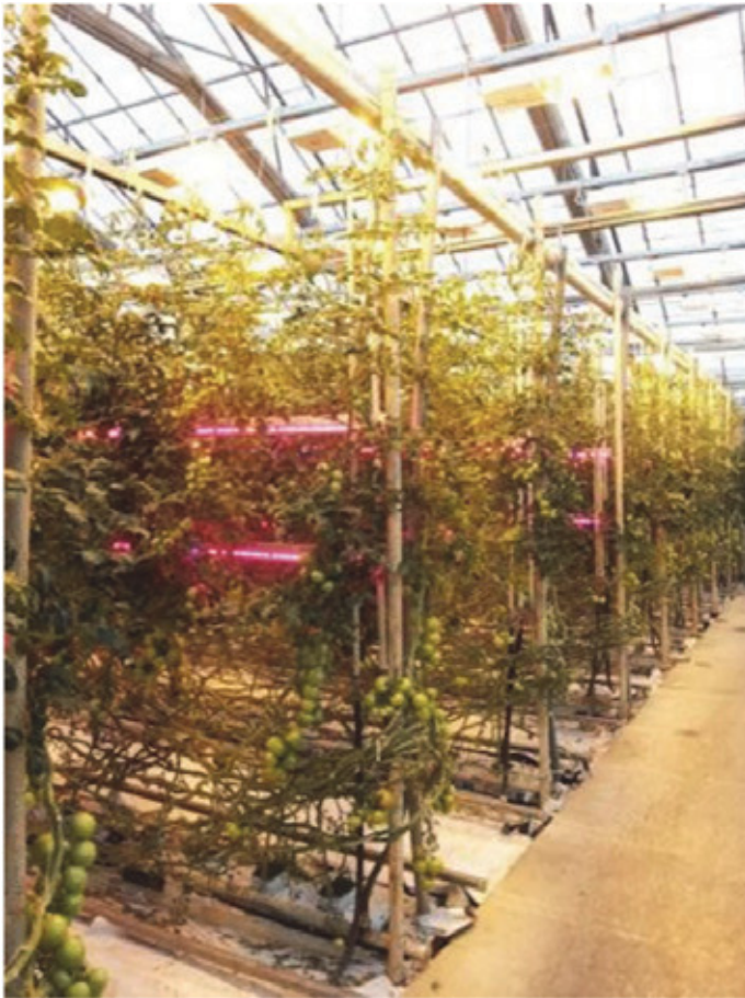
Bild 3. Philips GreenPower LED (dubbelinstallation) och HPS-toppbelysning (400 W per armatur). Bilden är fotograferad i ett av växthusodlarens åsväxthus. (Foto Daniel Sjöholm, 10.3.2014)
