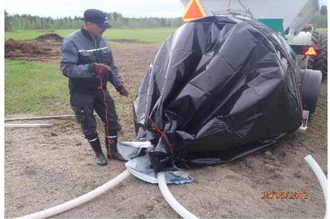
2. Salaojaputket ja pussin sulkeminen narulla
