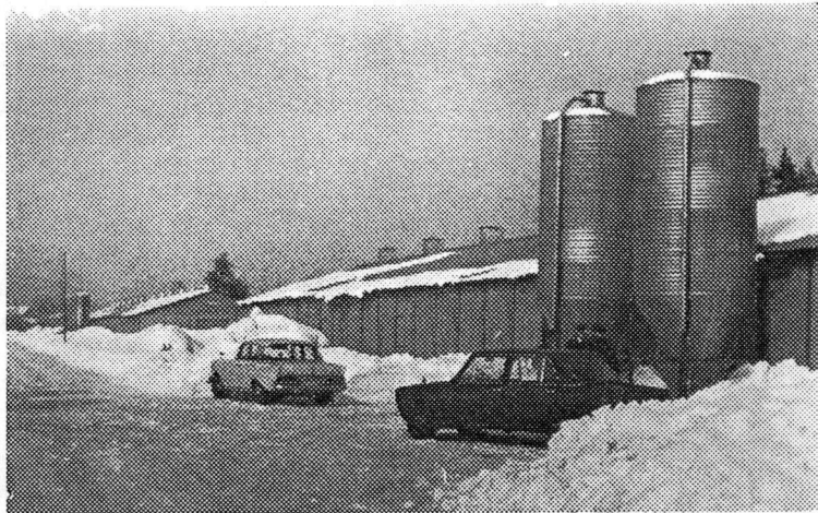
Ruotsalaisen broilerikasvattamon halleja. Kussakin rakennuksessa (14,1 m x 106 m) on kaksi hallia. Rakennuksen keskiosassa on ruokintalaitteiden koneistot, lämmityslaitteet (teho 130 000 kcal) ym. huoltotilaa. Kuvassa näkyvien rehusilojen puhdistusluukut olivat liian pienet. Siilojen alaosaan tiivistyi kosteutta.
