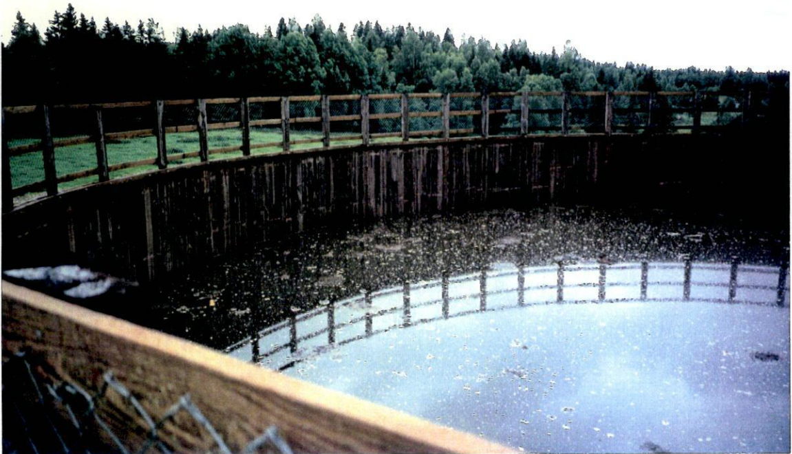
Kuva 3. Lietelantasäiliö, hyötytilavuus 1000 m 3 , on tehty pontatusta kreosottikyllästetystä lankusta. Säiliön vierustan täyttötyö on tehtävä huolellisesti, jotta vältetään seinän lommahtamiselta.
