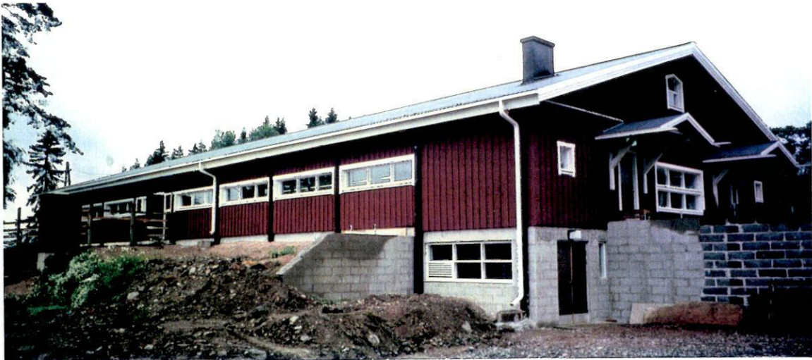
Kuva 2. Maituhuone, lämpökeskus ja polttoainevarasto on sijoitettu kellarikerrokseen, mikä on toiminnan kannalta edullinen ratkaisu.
