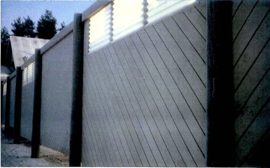
Kuva 11. Rakennuksen ulkoseinää. Aaltomainen muovilevyikkuna kiinnitetään suoraan runkorakenteisiin.
