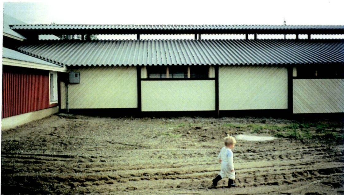
Kuva 10. Rakennuksen julkisivua. Näkyviin jäävä pystyrunko rytmittää vinolaudoitettuja julkisivukenttiä. Ikkunat on tehty aaltomaisesta muovilevyistä. Harjakorotuksen muovilevyikkunat vielä puuttuvat.
