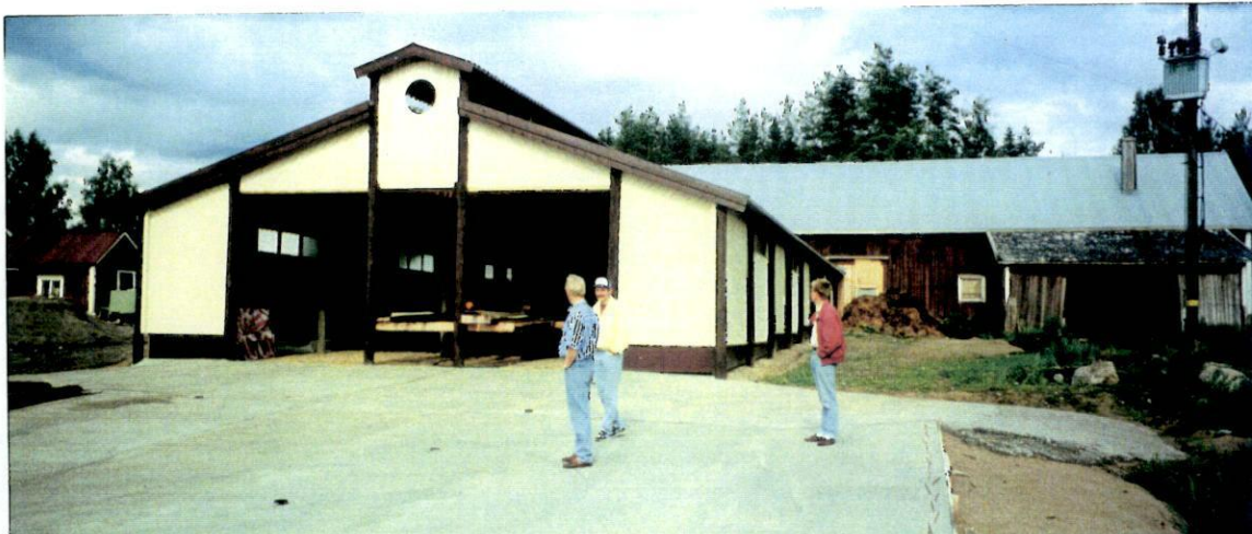
Kuva 9. Rakennuksen pääty. Kuivalantalan laattaa on levennetty, jolloin laatan osaa (kuvassa oikealla) voidaan käyttää tuorerehun varastointiin. Laatassa näkyy muunneltavan väliseinän runkoputkiston varaukset. Kun rehut on käytetty, koko laatta otetaan lantavarastoksi.
