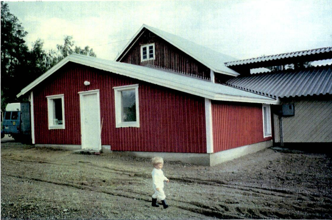
Kuva 14. Lypsyosasto-, maidonhuolto- ja sosiaalitalat on sijoitettu lämmöneristettyyn tilaan. Laajennusosan väri korostaa ihmisten työtilan ja eläintilan erilaista luonnetta.
