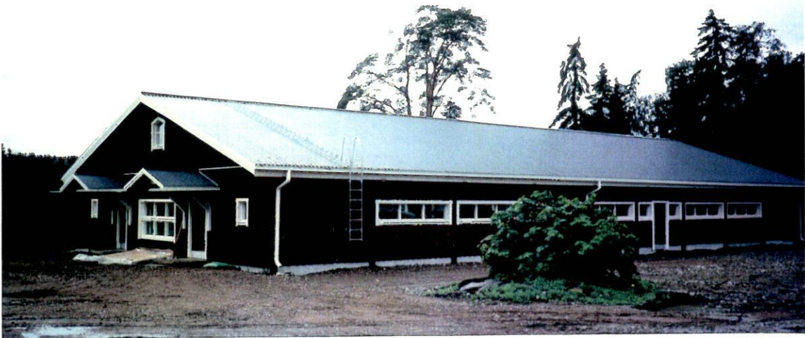
Kuva 1. Laitilan pihattonavetta. Kantavien kreosottikyllästettyjen pilareiden esiintuomisella on rytmitetty julkisivua. Rakennuksen ulkoseinät ja yläpohja on toteutettu kustannuksiltaan edullisilla, omatoimisesti valmistetuilla elementeillä.
