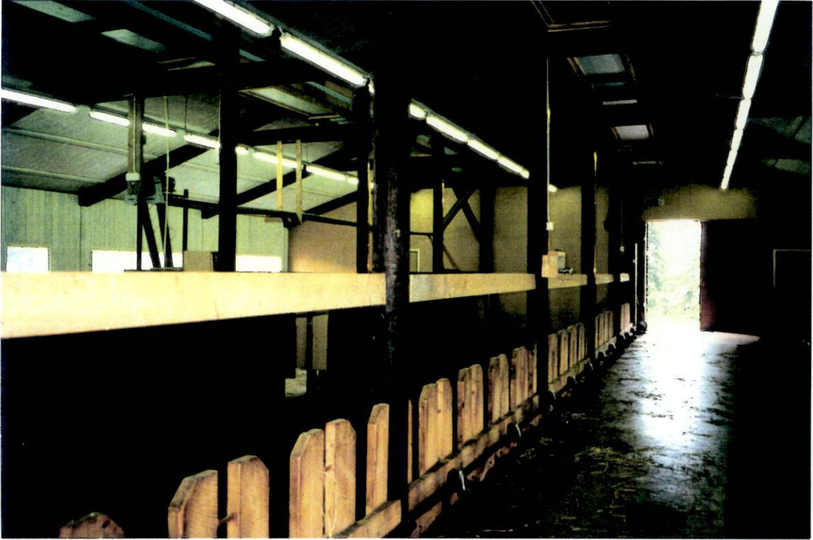
Kuva 6. Laitilan pihatto. Rakennuksen pystyrunko ja kattokannattajat on tehty kreosootikyllästetystä pyöreästä puutavarasta. Katto- ja seinäelementit on tehty paikalla. Seinien alaosan pintarakenteena on maalattu filmipintainen vaneri, muut pinnat on verhoiltu laudalla. Ruokintapöytä on puurakenteinen.
