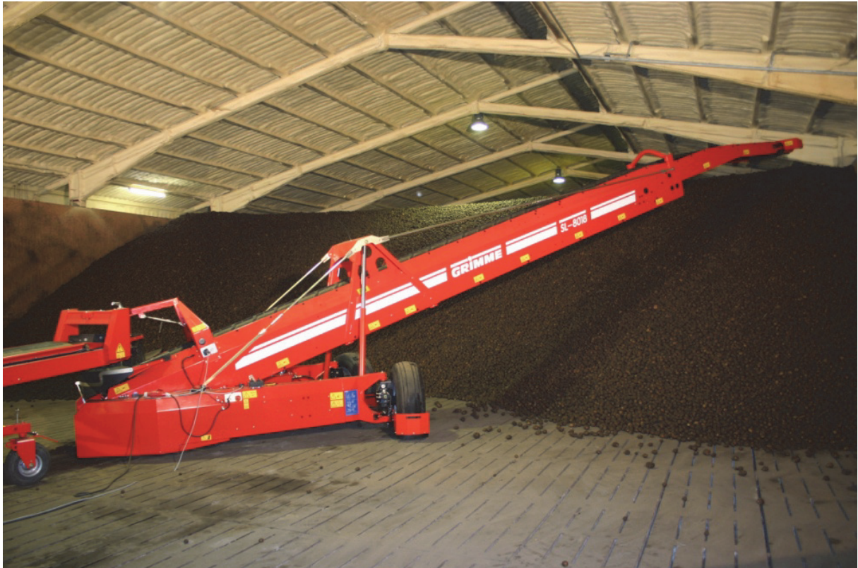
Kuva 2. Perunan irtovaraston täyttökuljetin, jossa elevaattorin pudotuspään korkeus säätyy siten, että perunoiden pudotuskorkeus on mahdollisimman pieni. (Kuva: www.grimme.com/de )
