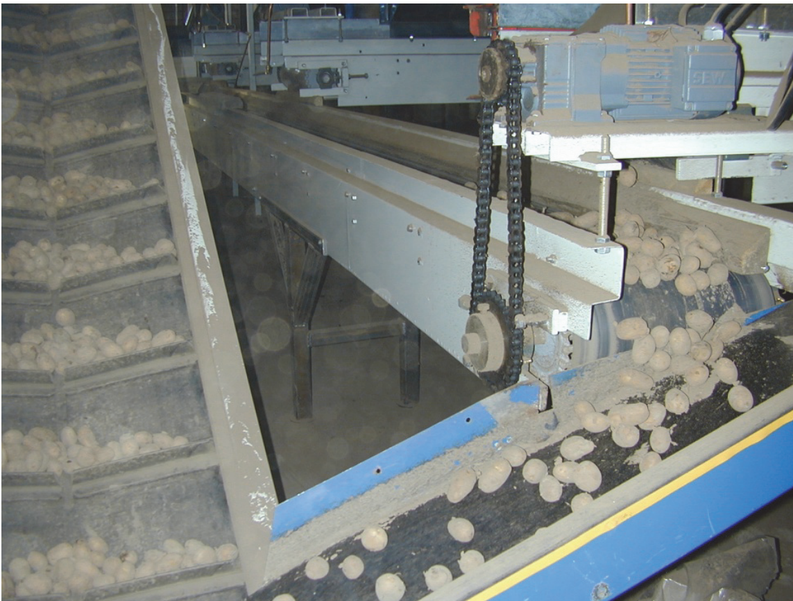
Kuva 10. Kolhiintuuko vai ei? Tärkeintä on pitää käsittelylinjaston pudotuskorkeudet pieninä, huolehtia vaimenninmateriaalien kunnosta ja käsitellä vain lämmitettyä perunaa. Kuvassa työturvallisuusasiat eivät ole ihan kunnossa puuttuvan ketjunsuojan takia. (Kuva: Timo Lötjönen)
