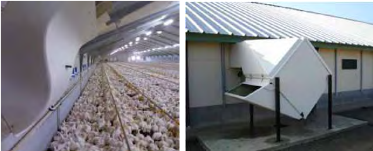
Kuva 68. Esimerkki broilerikasvattamon lämmön talteenottokoneesta (Skov). Laitteen ristivirtalämmönsiirrin on polypropyleeniä ja kuori lasikuitua. Valmistaja ilmoittaa laitteen riittävän 10 000 broilerille. Hallin puolella tuloilman suuntaus on säädettävissä.
