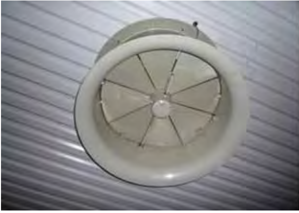
Kuva 21. Hallin poistoilmakanava kiinni ja auki asennossa. Kanavan alareuna on noin 60 cm etäisyydellä kattopinnasta. Hallin sisäkorkeus on 3,7 m.
