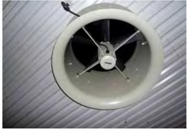
Kuva 21. Hallin poistoilmakanava kiinni ja auki asennossa. Kanavan alareuna on noin 60 cm etäisyydellä kattopinnasta. Hallin sisäkorkeus on 3,7 m.
