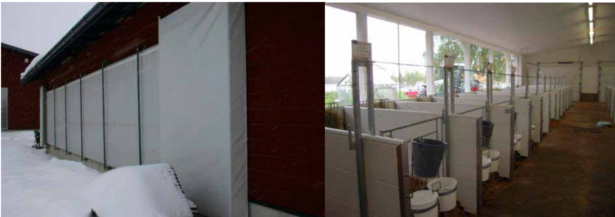
Kuva 1. Vasikoiden verhoseinähalleja talvi- ja kesäaenoissa. Kuvat ovat eri halleista. Kuvaaja: Tea Elstob (vasen) ja Reetta Palva (oikea).
