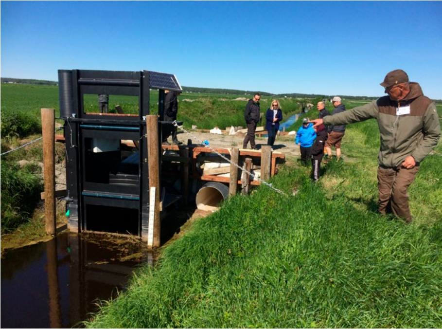
Valtaojan säätöpato Söderfjärdenin koekentällä. Kuva: Terhi Ajosenpää.
