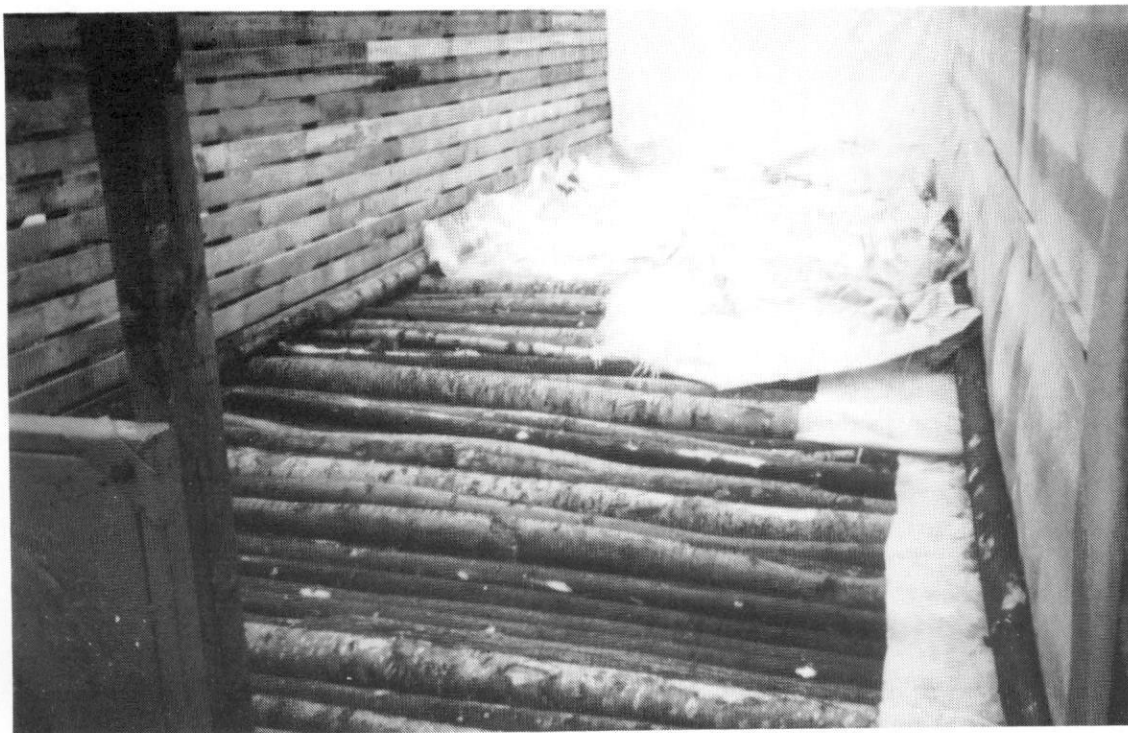
Kuva 6. Hakekuivurin pohjan rakenne. Alla on hakerangoja, jotka on peitetty suursäkeillä. Päätyseinässä on muovi, joka ohjaa ilman virtausta. Kuvassa näkyy myös kaksi seinävaihtoehtoa. Vasemmalla on lautaseinä. Oikealla harva laudoitus on peitetty maanrakennuskankaalla.
