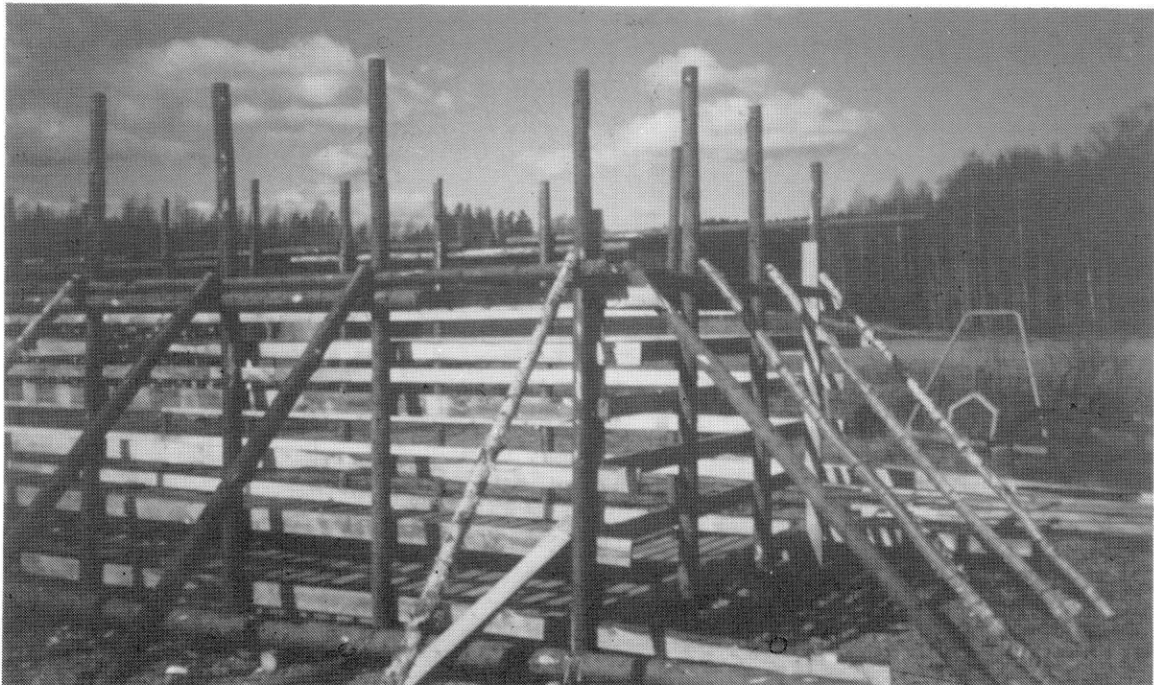
Kuva 5. Hakekuivuri runkovalmiina, katto ja seinän verhoilu puuttuvat.
