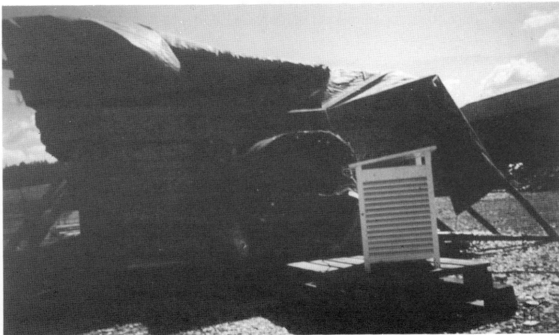
Kuva 8. Auringonkerääjäkatto sidottuna kuivurin päälle. Katto jatkuu eteläpuolella melkein maahan asti muodostaen ilmaa lämmittävän tilan ja pinnan.
