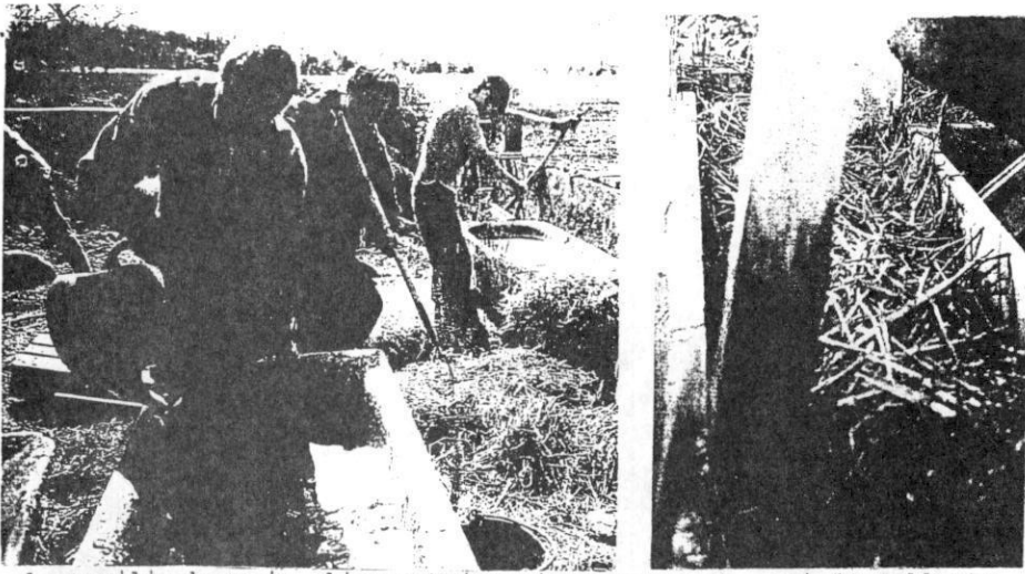
1. saviliuksen ja oljen sekoittaminen massaksi, seinän sullonta
