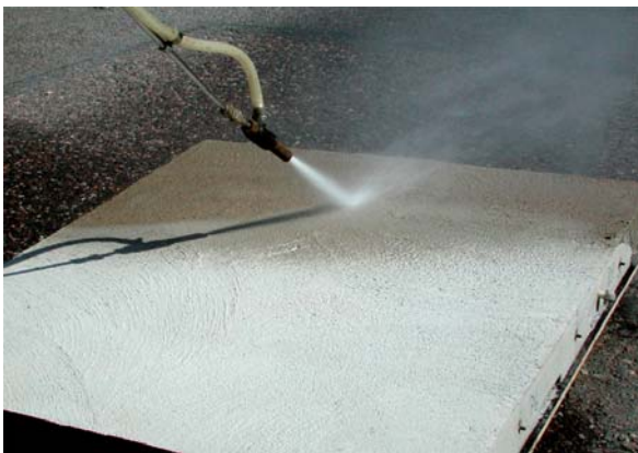
e) puuhierretyn alusbetonilaatan vesihiekkapuhallus
