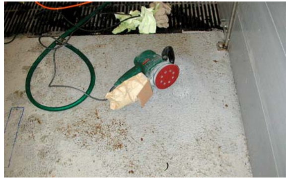
b) lattiapinnoitteen hionta
