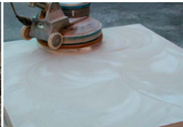
f) teräshierretyn alusbetonilaatan konehionta
