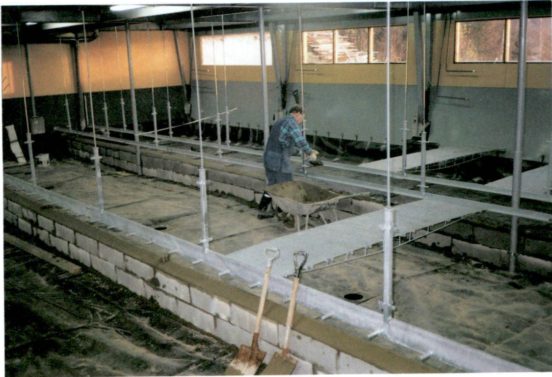
Kuva 2. Alapohjassa muovikalvo, jossa on läpiviennit lannanpoistoa varten, ja sen päälle muuratut lietealtaan seinät, joiden yläreuna pyöristetään betonilla. Vieroituskarsinoiden ripustukset välipohjarakenteesta ovat jo paikoillaan ja ensimmäiset itsekantavat teräsritilät asennettu.
