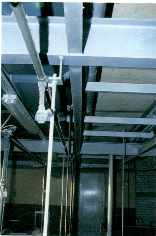
Kuva 4. Välipohjan rakenne. Primääripalkit, joiden väliin on hitsattu sekundääripalkit. Vieroitusosaston reunimmaisten karsinoiden käytävän puoleinen reuna on ripustettu primääripalkkiin hitsatulla kierretangolla (edessä vasemmalla) ja keskimmäisten karsinoiden käytävän puoleinen reuna apupalkkiin pulttaamalla (takana oikealla). Yläpuolisen porsitusosaston lannanpoistoputki näkyy sekundääripalkin vieressä.
