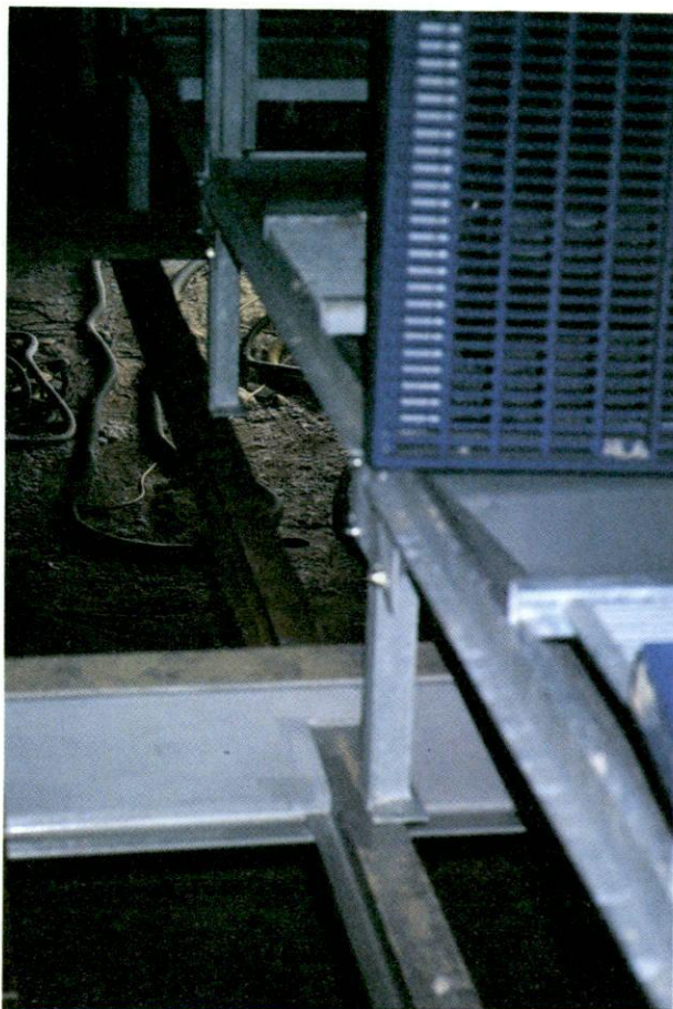
Kuva 5. Porsituskarsinat kootaan suoraan sekundääripalkkien varaan. Etureunassa olevan ulokkeen päälle asennetaan käytävälevyt, jolloin emakot ja hoitajat ovat samalla tasolla.
