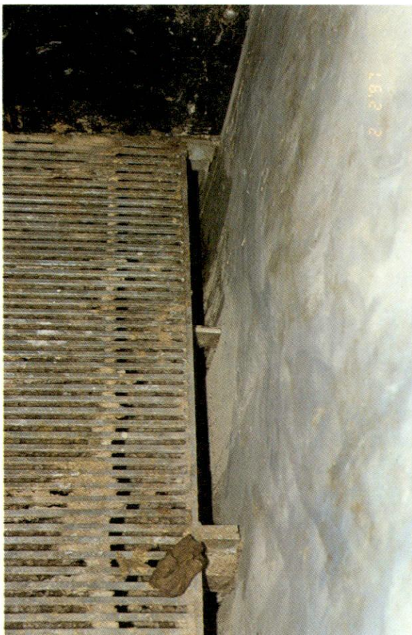
Kuva 9. Vieroituskarsinoiden ritilän ja seinän väliin on jätetty pieni rako, josta lanta putoaa suoraan lietealtaaseen. Ensimmäisten kasvatuserien aikana systeemi on toiminut hyvin eikä karsinoita ole tarvinnut käydä käsin siivoamassa.
