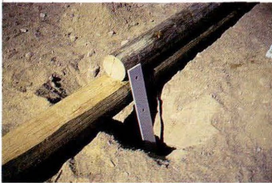
Kuva 3. Tukirautojen kiinnitysbetonimonttu kairattu sorapatjaan
