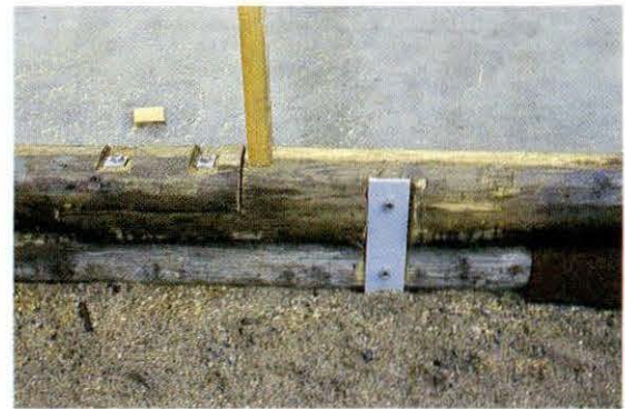
Kuva 4. Lattialaatta valettu, sokkelihirsien pituusjatkos, kiinnitysraudat pultattu paikoilleen.
