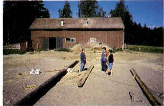
Kuva 2. Painekyllästettyjä sokkelihirsitä aseteltu paikoilleen.
