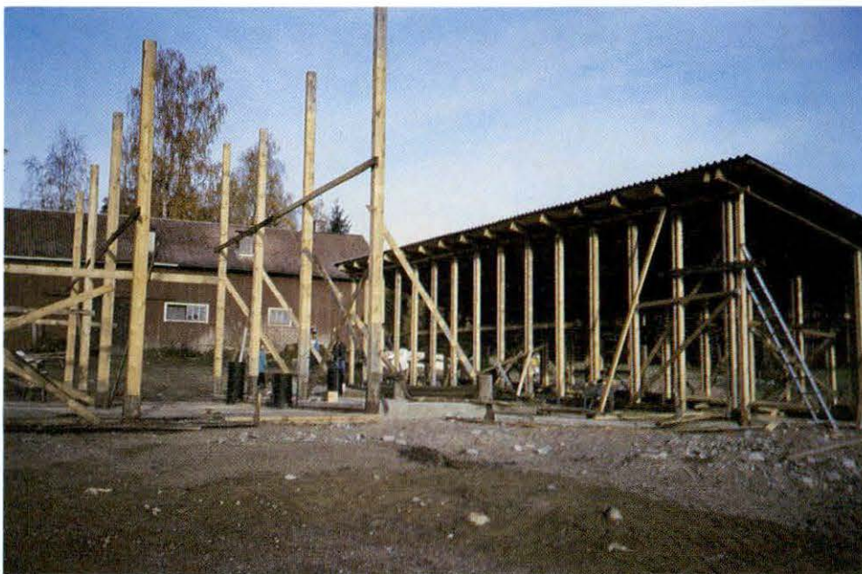
Kuva 5. Perustukset ja laattavalut valmiit, runko rakenteilla.
