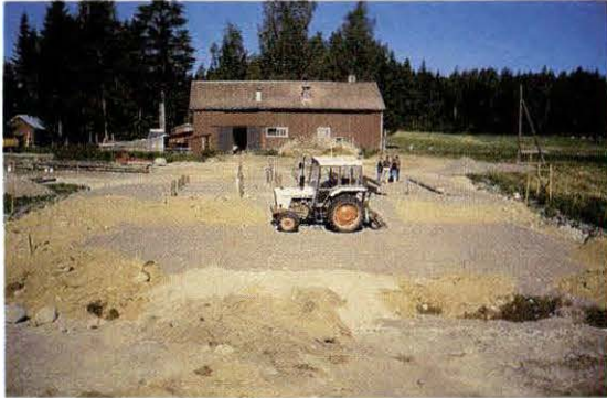
Kuva 1. Pintamaa poistettu ja 500 mm:n sorapatja levitetty sekä painekyllästetyt perustuspilarit kairattu paikoilleen.
