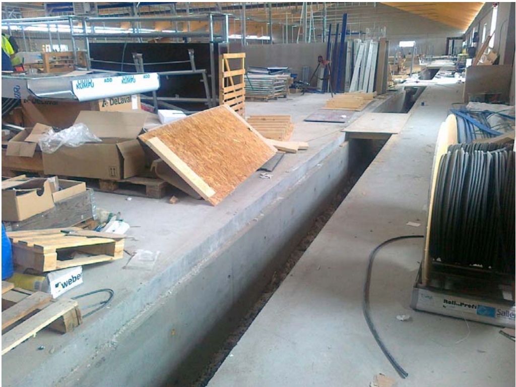
Kuva 4. Rakennustyömaan hyvä järjestys ja siisteys sekä ulkona että sisällä ovat edellytyksiä hyväälle työturvallisuudelle. Näin ei kuitenkaan aina ole! Kuvat: Tapani Kivinen ja Kim Kaustell.
