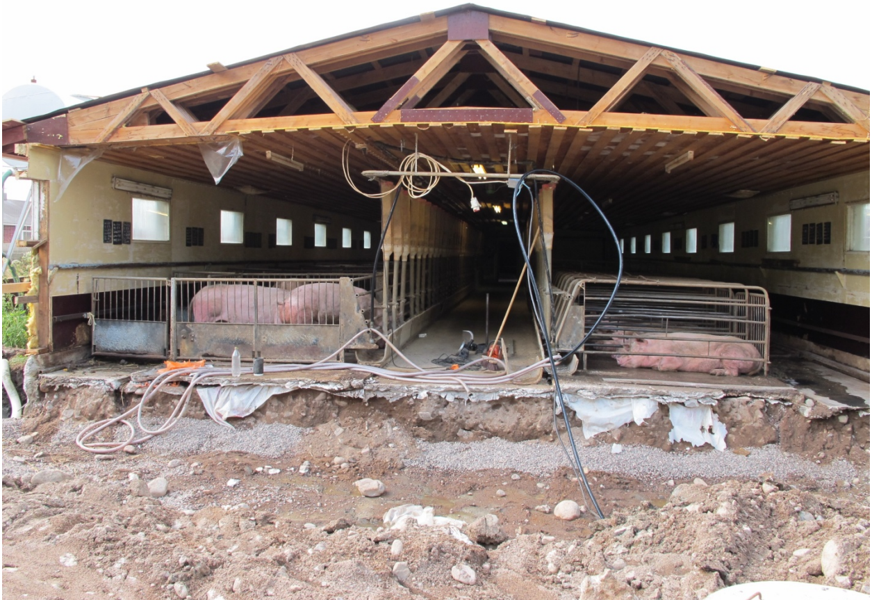
Kuva 7. Vanhaa emakkosikalaa on lyhennetty noin 2 metriä, että uudisrakennus saadaan linjattua kulmitain vanhaan nähden. Purkutyötä hankaloitti se, että tuotanto oli koko ajan käynnissä ja eläimet karsinoimaan. Purkutyössä isäntä sai parrun päähänsä. Myös purkutyömaalla työmaan siisteyteen kannattaa kiinnittää huomiota. Kuva: Tapani Kivinen.
