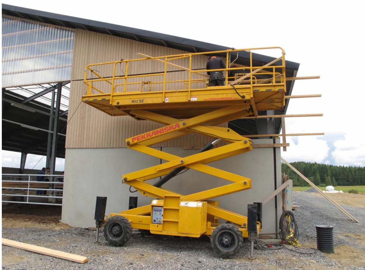
Kuva 8: Esimerkki asiallisesta julkisivulaudoitustyöstä henkilönostimen avulla. Kuva: Tapani Kivinen
