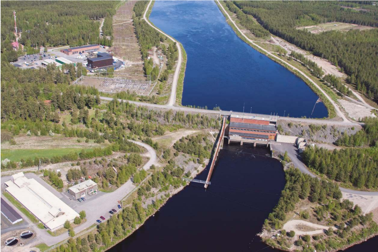
Kuva 13. Raasakan voimalaitos alavirrasta päin kuvattuna. Kuva: PVO-Vesivoima Oy.
