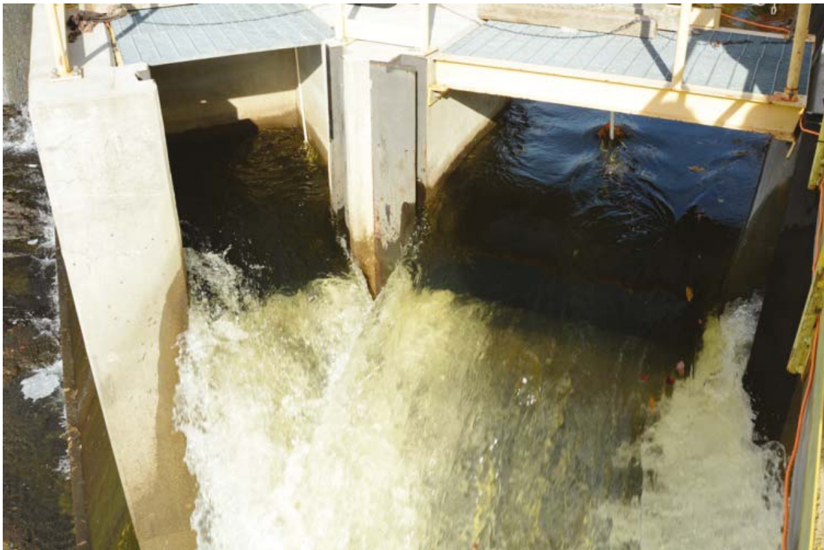
Kuva 21. Alasvaellusväylän sisäänkäynnin virtausolosuhteet ovat keskeisiä koko ratkaisun toimivuuden kannalta. Virtauksen pitää houkuttaa kala sisäänkäynnille ja lopulta estää kalan paluu takaisin ylävirtaan. Kuva: Panu Orell.
