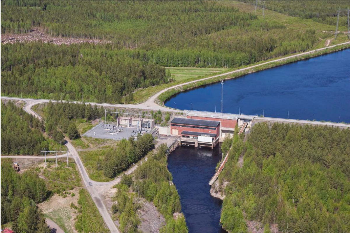
Kuva 11. Maalismaan voimalaitos alavirrasta päin kuvattuna. Kuva: PVO-Vesivoima Oy.
