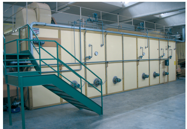
Kuva 3. Käpyjen karistusuuni Perin siemenkeskuksessa. Kävyt kulkevat uunin läpi liukuhihnaa pitkin. Karistuslämpötila on useimmilla havupuilla +40 °C (Douglaskuusella +48 °C). (Kuva Pekka Helenius).
