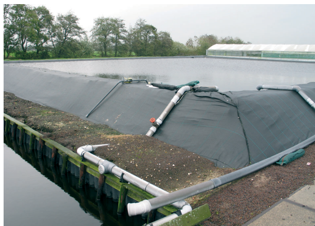
Kuva 1. Van leeuwen tarhan ulkoalueilta maa- ja hohkakivikerroksen läpi suodattanut kastelu- ja sadevesi kerättiin 3000 m 3 ulkoaltaaseen (kuvassa verhottu muovilla), josta vesi johdettiin kastelulaitteisiin uudelleen käytettäväksi. Kuvassa on nähtävissä myös tarhan sijainti aivan kanavaverkoston äärellä. (Kuva Risto Rikala).
