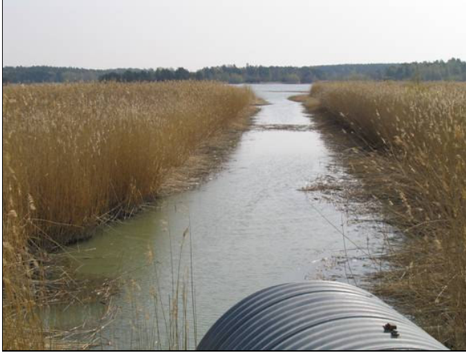
Kuva 44. Toimenpidekanava alueella 18 (kuva: RKTL).
