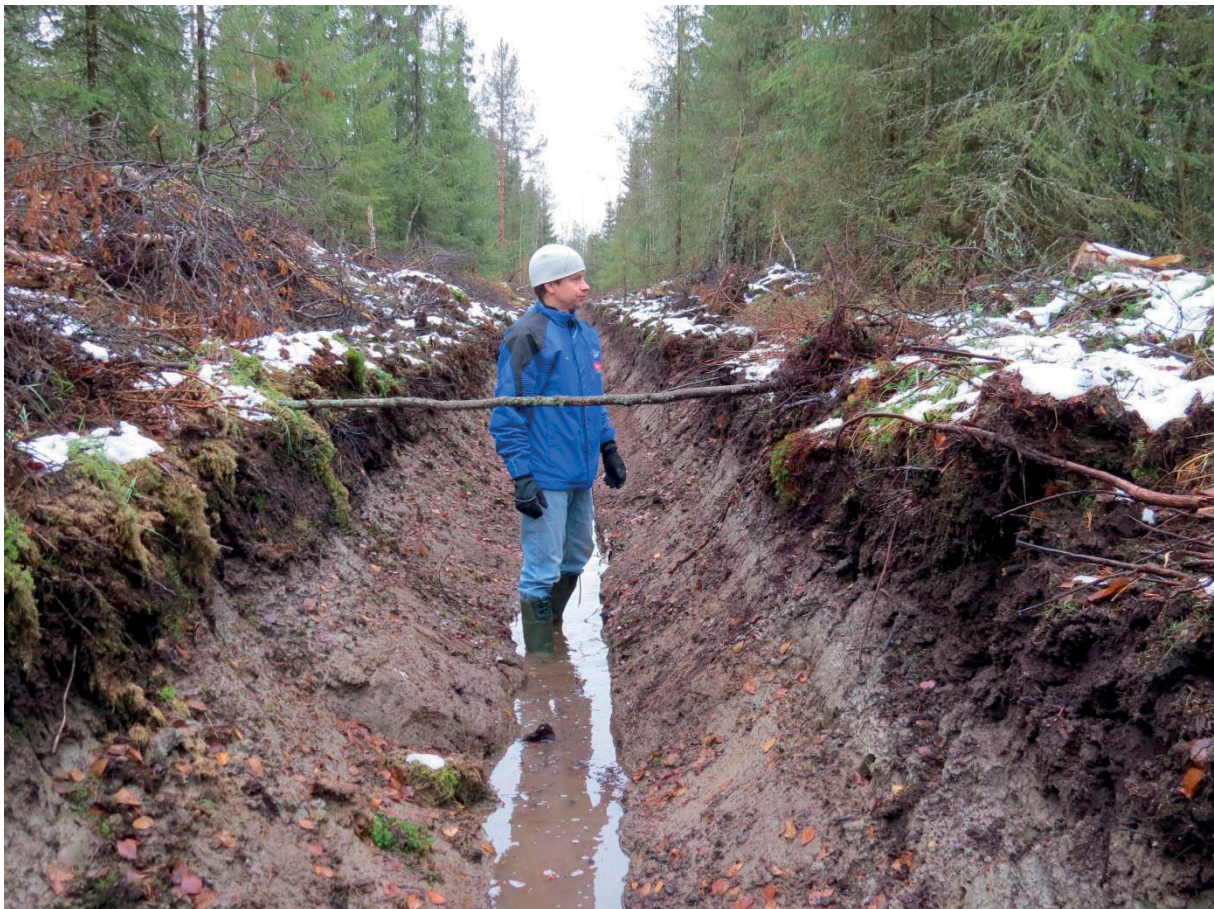
Tarpeettoman syväksi kaivettu sarkaoja happamalla sulfaattimaalla Tervolassa. Kuvassa on tyypillinen ohutturpeinen viljava korpi, jossa pohjamaa on sulfidipitoista hienoa hiesua. Vanhat sarkaojat on perattu 1,2 -1,3 metriä syviksi. Kuva: Hannu Hökkä.
