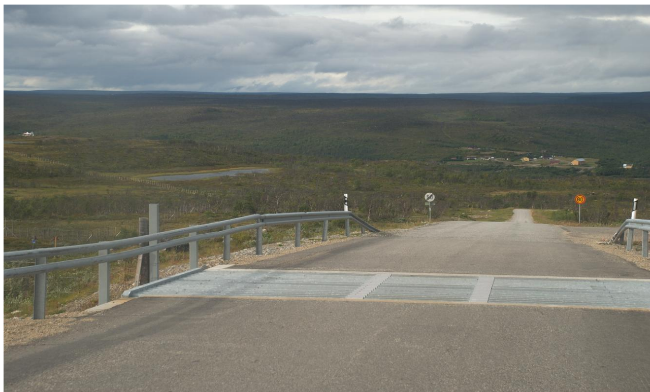
Kuva 6. Peurasilta (kustannusarvio vuonna 2007 noin 80 000 euroa) Suomen poroesteaidan ylityspaikassa Nuorgam-Pulmankijärvi välisellä tiellä. Etelästä tuleva ja Nuorgamin itäpuolella kulkeva uusittu poroesteaita on kuvassa vasemmalla. Kuva Mauri Nieminen.
