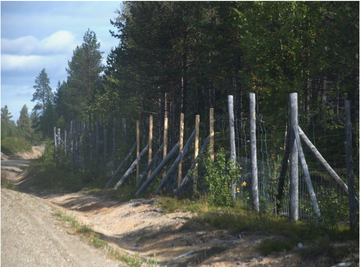
Kuva 3. Suomen poroesteaita (yhteensä 235 km) kulkee Angelista Pulmankiin Inari- ja Tenojoen ja pääosin myös seututien nro 9704 ja 970 itäpuolella. Aita on 180 cm korkeaa lanka- ja verkkoaitaa. Kuva Mauri Nieminen.
