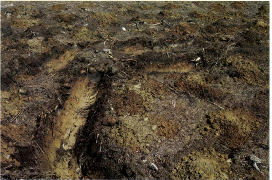
Kuva 18. Naveromätästystä kaivinkoneen kauhalla (yllä) sekä matala navero ja siitä tehtyjä ojamättäitä (alla).
