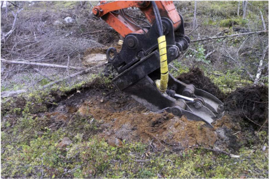
Kuva 17. Laikkumätästystä muokkauslevyllä. Yläkuvassa maakerros irroteaan levyllä maasta. Alakuvassa irrotettu maakerros käännetään koskemattomalle maalle siten, että humuskerros jää alle ja kivennäismaa pinnalle.
