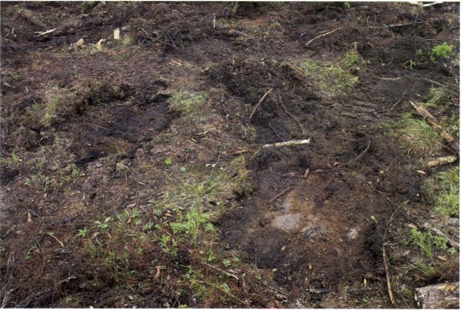
Kuva 11. Laikutusta kaivinkoneen kauhan kärjellä (yllä) ja valmiita laikkuja, joissa humus on poistettu kivennäismaan pinnalta (alla).
