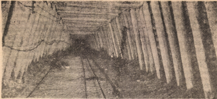
Eräs kuljetuskäytävän tukirakenne.
