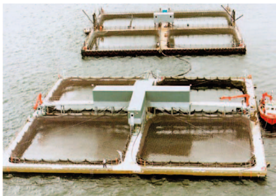
Kuva 7. Skotlantilaisen Campbeltown Developments Ltd:n Cruive-kehikko perustuu jäykkiin rakenteisiin.
