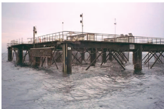
Kuva 6. Ainakin neljä espanjalaisen Marina System Iberica -yhtiön järjestelmää on käytössä Välime-rellä. Rakennelman pinta-ala on noin 2 500 m 2 . Tukipilarit ulottuvat 9–10 metriä pinnan alle. Kannella on mm. rehuvarasto, generaattori ja pieni miehistöhytti (kuva: Marina Systems Iberica).
