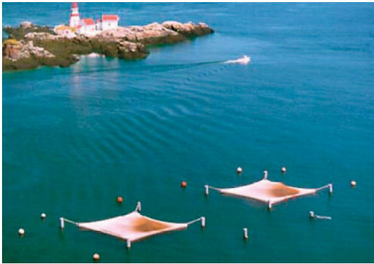
Kuva 10. OceanSpar-yhtiön AquaSpar-ratkaisussa upotettu verkkoallas pingotetaan neljän poiijun varaan. Järjestelmiä on muun muassa Kanadassa (vasen kuva) ja Espanjassa (kuva: OceanSpar).
