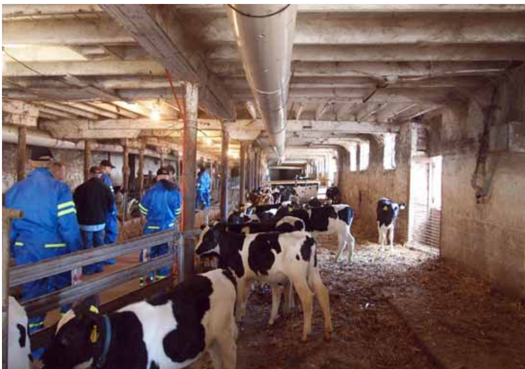
Kuva 13. Ylipainepuhallus asennettuna vanhoihin vasikkatiloihin. Ylipainepuhallukseen siirryttäessä vanhan rakennuksen tiiveys on purettava esimerkiksi poistamalla ikkunat ja asentamalla säädettävät kennolevyt tai verhot tilalle. Puhaltimen ja kanavan kustannukset ovat pienet. Ylipainepuhalluksella saavutetaan merkittävä parannus vasikoiden lähiympäristön ilmanlaatuun pienellä vaivalla. Kuva: Tapani Kivinen.
