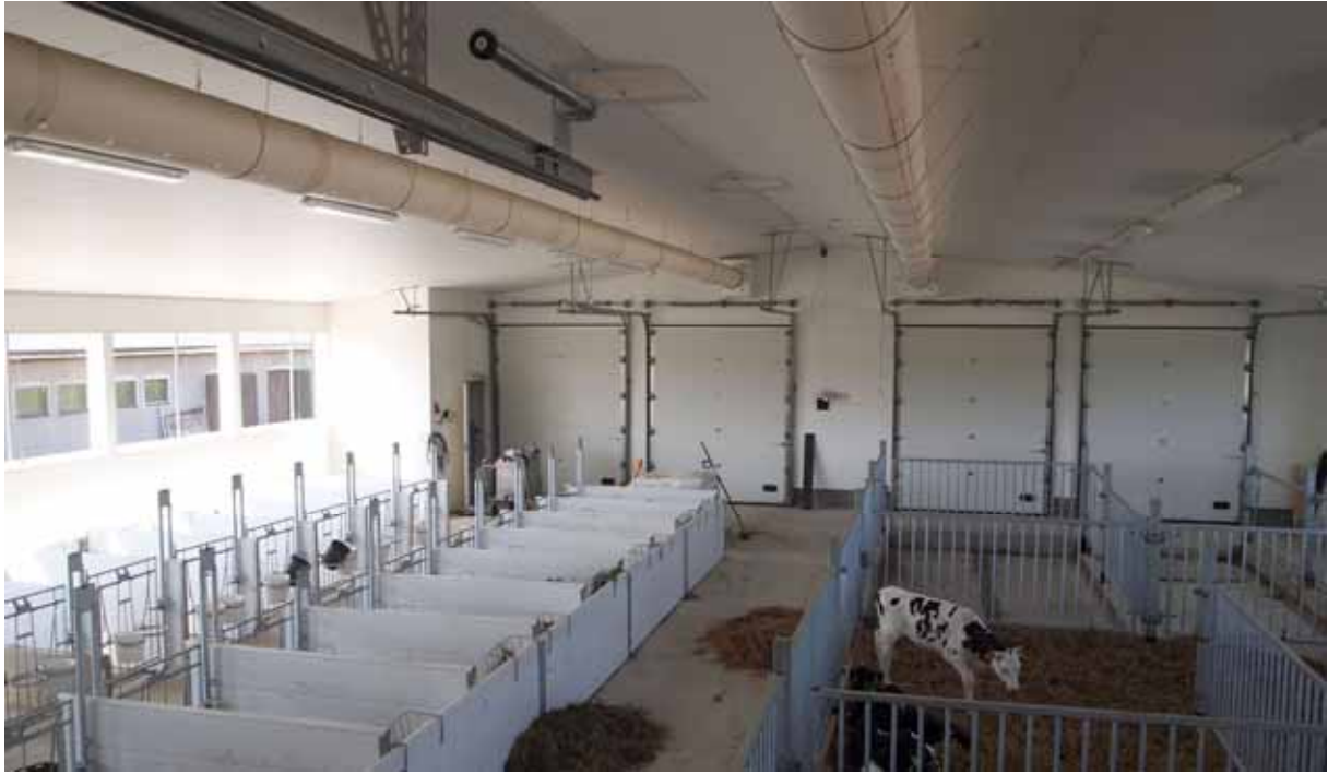
Kuva 14. Ylipainepuhalluksen toteutus Pohjois-Savolaisessa vasikkatalossa. Kuvassa vasemmalla yksilökarsinoiden rivi ja oikealla ryhmäkarsinat. Puhalluskanavat on ripustettu teräsköysillä kattorakenteesta. Kanavien optimaalisin sijoitus olisi ollut rivien keskellä, mutta päätykolmion muoto ja ovien mitat ovat rajoittaneet sijoitusmahdollisuuksia. Ilman sisäänotto tapahtuu rakennuksen pohjoisjulkisivulta. Kuva: Tapani Kivinen.
