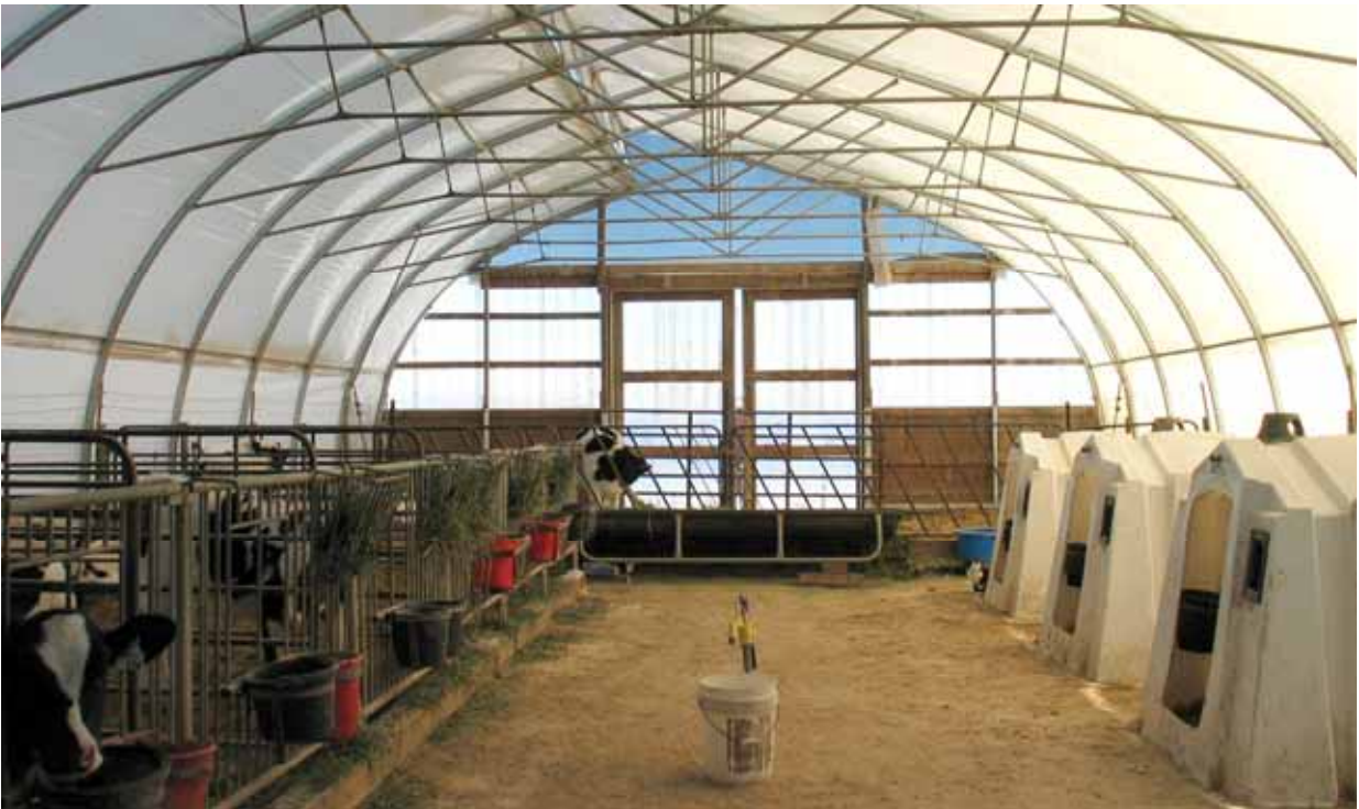
Kuva 25. Esimerkki vasikoiden alkukasvatusympäristöstä kasvihuoneessa, jonka lattia on betonia. Oikealla yksittäisiä igluja, vasemmalla ryhmäkarsinoita. Ilmanvaihto tapahtuu päätyjen yläkolmion ja harjaukon kautta. Kuva: Tapani Kivinen.
