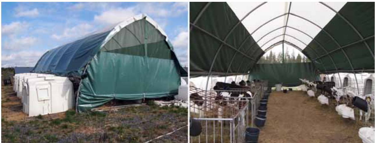
Kuva 24. Esimerkki osittain katetusta igluryhmästä. Teräsputkikaarista ja pressumuovista on koottu sadekatos iglujen huoltoalueen päälle. Juotto, kuivitus ja lannanpoisto helpottuvat huomattavasti erityisesti lumisina talvina. Lumi saa pudota iglujen päälle ja väleihin, koska se osaltaan toimii lämpöeristeenä talvisin. Kuva: Tapani Kivinen.
