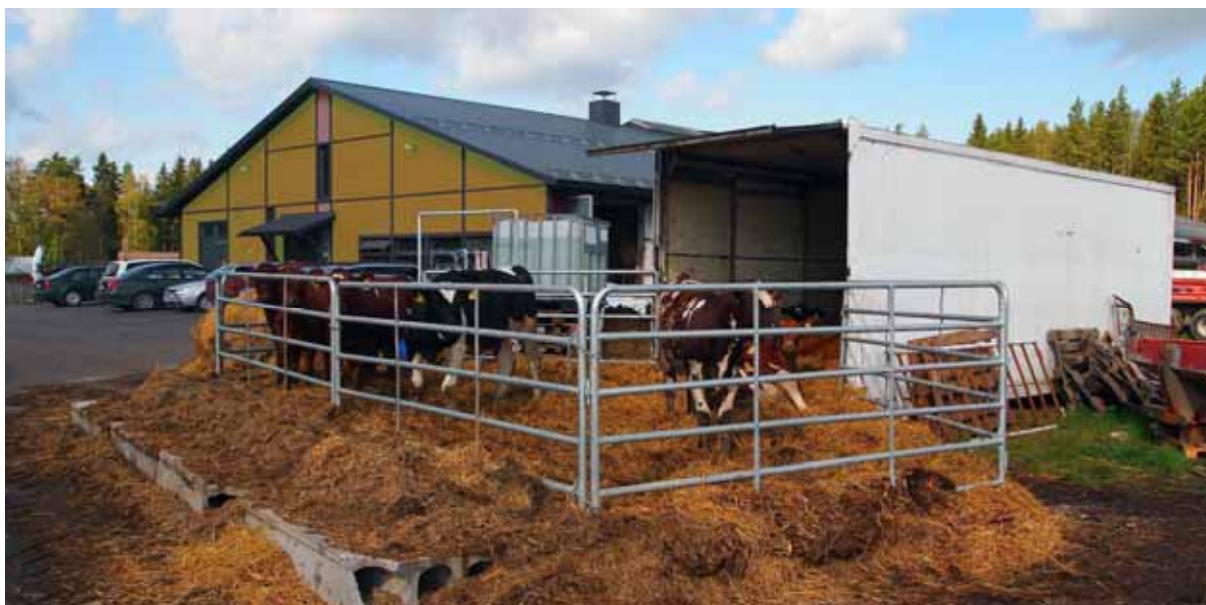
Kuva 19. Esimerkki tilapäisluonteisesta vasikkatilaratkaisusta. Käytöstä poistettu kuorma-auton konttilava toimii vasikoiden suojatilana. Ulkotarhan alustana toimivat käytetyt ontelolaatat. Suojatilana voidaan käyttää myös käytöstä poistettuja merikontteja. Niiden metalliseinät voivat olla talvella kylmän tuntuisia, joten seinien alaosiin on syytä asentaa vanerilevyt. Kuva: Tapani Kivinen.
