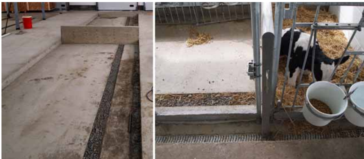
Kuva 37. Kuvia vasikkatalon rakenteellisista ratkaisuista. Vasemmalla yksilökarsinarivin keskellä sijaitseva kiinteä betoniseinäke, jota vasten etukauha voidaan työntää lannanpoistossa. Vasemmassa kuvassa näkyvät myös erilliset nesteidenkeruu-urat. Oikeassa kuvassa urien väliin on valettu kannas, joka estää pesuvesiä ja ämpäreistä roiskuvia nesteitä tunkeutumasta kuivikealueelle.
