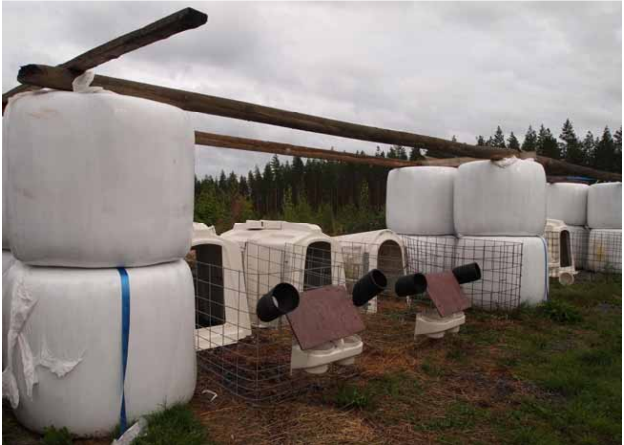
Kuva 23. Esimerkki erittäin edullisesta sääkatoksesta. Rehupaaleista on koottu kannatinseinät, joiden varaan on asennettu vanhat puhelinpylväät kantaviksi palkeiksi. Niiden päälle tulee vesikatto itsekantavasta profiilipelistä (kuvanottohetkellä pelti vielä puuttuu). Rakennelmaa voi täydentää vielä siten, että iglujen taakse kasataan lisää paaleja lumituiskuja vastaan. Kuva: Tapani Kivinen.
