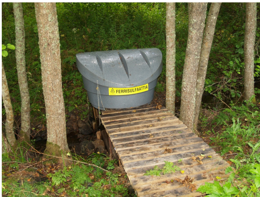
Kuva 7. Nuutajärventien varrelle rakennettu uusi kohde varustettiin paremmalla annostelusäiliöllä, jonka kannen välistä sadevesi ei päässyt säiliöön.
