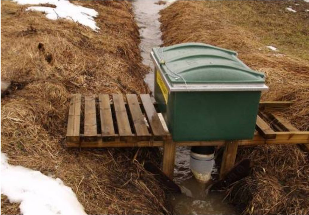
Kuva 5. Keskikokoinen annostelija varustettuna v-padolla, jonka avautumiskulma on 90 astetta.
