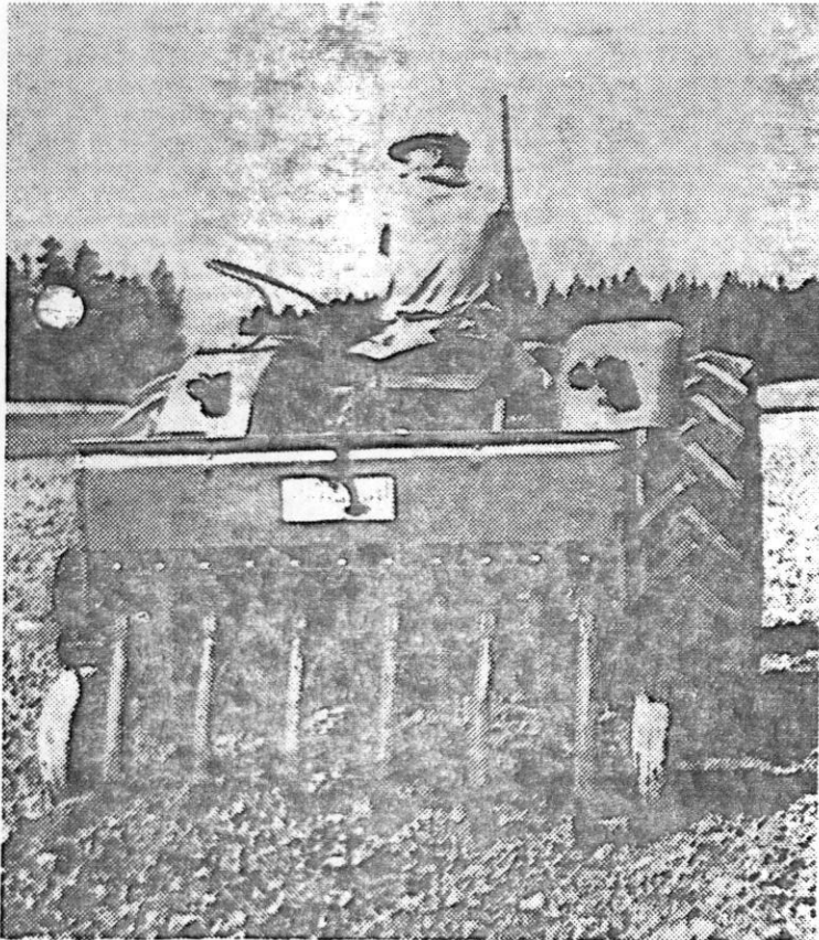
Kuva 1. Maatalouskoneiden tutkimuslaitoksella suunniteltu rivilannoitimen ensimmäinen koekappale.
