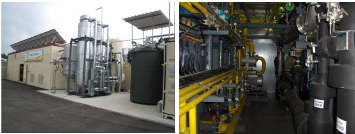
Kuva 2.8. Biokaasun puhdistuslaitteisto maakaasuverkkoon injektointia varten (Laupheim, Saksa). Kuvat: Teija Paavola ja Sari Luostarinen, MTT.
