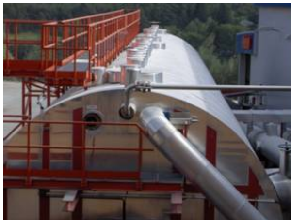
Kuva 2.3. Autotallimallinen biokaasulaitos (vas.), Münchenin eläintarha, Saksa (Kuva: Sari Luostarinen, MTT) sekä tulppavirtaukseen perustuva biokaasulaitos (oik.), Thöni, Saksa (Kuva: Teija Paavola, MTT).
