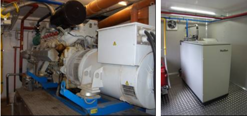
Kuva 2.6. CHP-generaattorit (kaasumootori): vasemmalla Karlen maatila, Saksa, oikealla MTT Maaningan biokaasulaitos. Kuvat: Teija Paavola ja Sari Luostarinen, MTT.
