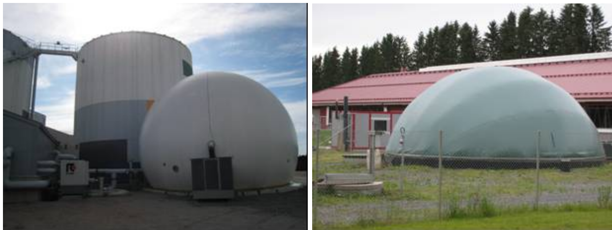
Kuva 2.4. Biokaasuvarasto voi olla kaasukello (vasemmalla Biovakka Suomi Oy:n Turun laitos) tai kaasuhippu reaktorin / jälkikaasualtaan päällä (oikealla MTT Maaningan biokaasulaitoksen reaktori). Kuvat: Sari Luostarinen, MTT.
