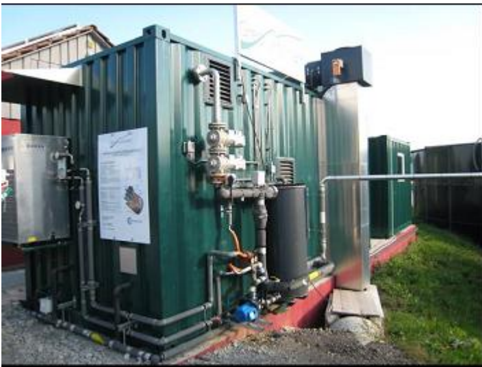
Kuva 2.7. Biokaasulle soveltuva mikroturbiini. Greenenvironment Ltd. Kuva: Sari Luostarinen, MTT.
