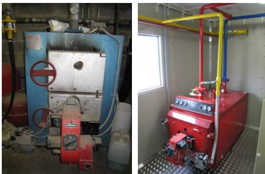
Kuva 2.5. Oilonin lämpökattilat biokaasulle soveltuvilla polttimilla (vasemmalla Kalmarin tila, Laukaa; oikealla MTT Maaningan biokaasulaitos). Kuvat: Sari Luostarinen, MTT.
