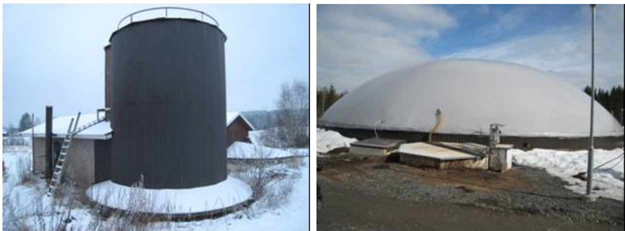
Kuva 2.2. Jatkuvasekoitteinen pystyreaktori (Kalmarin tilan vanha reaktori, Laukaa, vasemmalla) sekä maan alle sijoitettu reaktori (Bioson Oy, Juva, oikealla). Kuvat: Sari Luostarinen, MTT.
