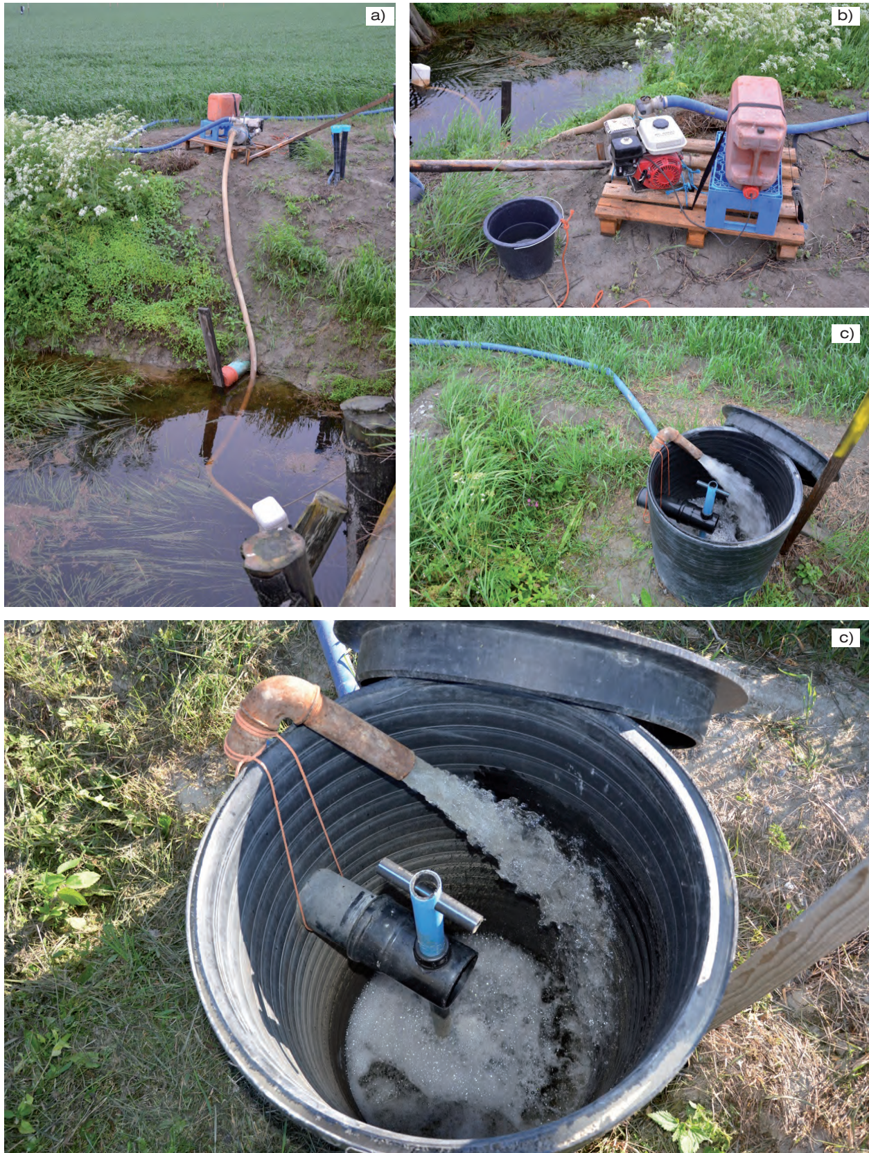
Kuva 13. Lisäveden pumpaus käynnissä läheisestä avo-ojasta salaojakaivon kautta ojastoon. Valtaojaan asennettu imuletku (a). Pumppu (b), joka toimii keskeytyksettä vuorokauden siihen liitetyn lisäpolttoainekanisterin avulla. Lisävettä virtaa säätökaivoon (c). (Kuvat: Rainer Rosendahl)
