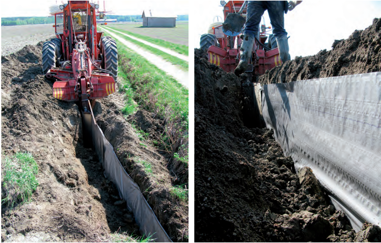
Kuva 14. Ylhäällä vasemmalla muovikalvon asentaminen 1,8 m:n syvyyteen. Ylhäällä oikealla kaivantoa täytetään happamalla kaivumaalla ja lopuksi kaivannon päälle levitetään siitä poistettu muokkauskerroksen maa. Näin vältetään happaman kaivumaan sekoittuminen muokkauskerrokseen. Alhaalla salaojituskone muovinasennuslaitteineen. (Kuvat: Rainer Rosendahl)
