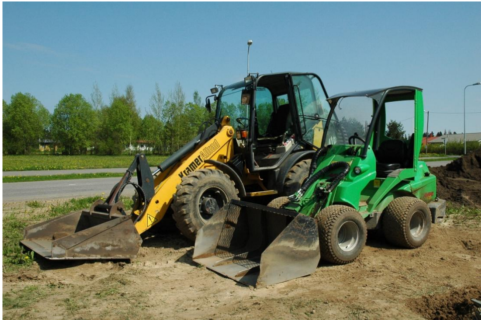
Kuva 3. Perustamisessa käytetyt koneet.
