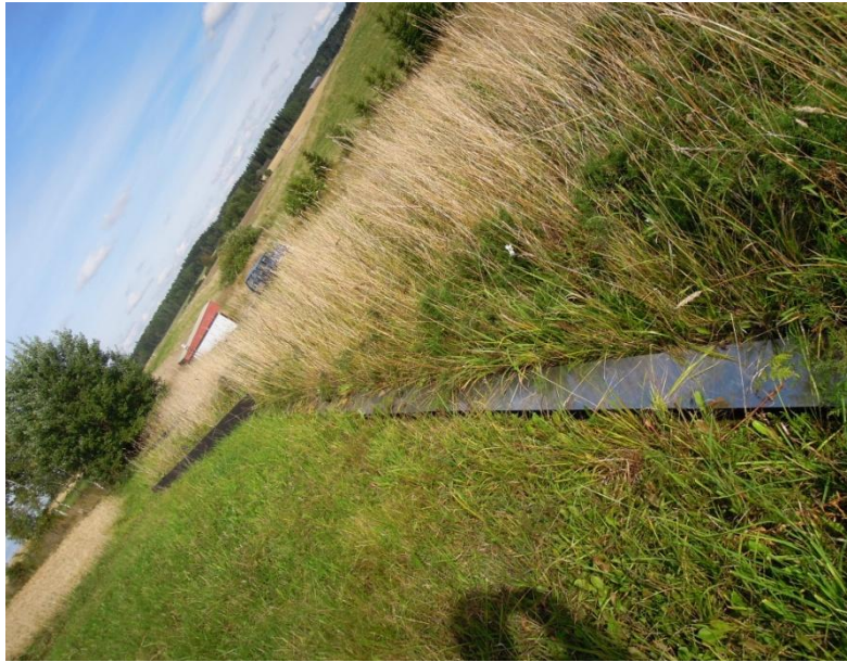
Kuva 4. Pintavesikeräin. Kuva: Ari Seppänen
